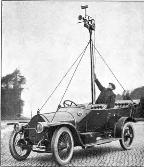
Abb. 8. Eichung der Druckscheibe auf Kraftwagen.
