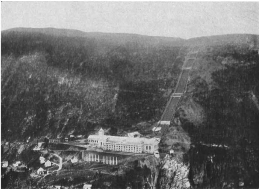
Abb. 172. Kraftstation Rjukan I bei Vemork mit Röhrenleitung.
