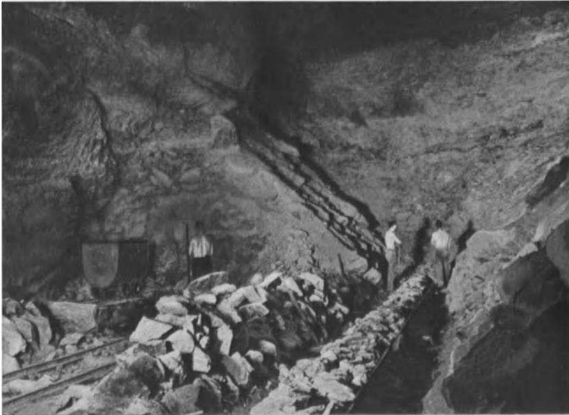
Abb. 64. Förderung der losgeschossenen Kalisalze mittels Schüttelrutsche zur Förderstrecke.
