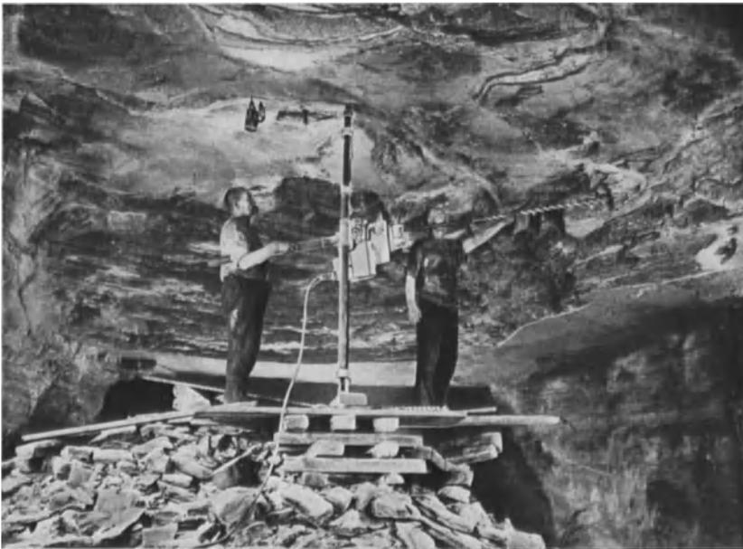
Abb. 63. Bohrarbeit im Sylvinit mit der elektrisch angetriebenen Bohrmaschine.
