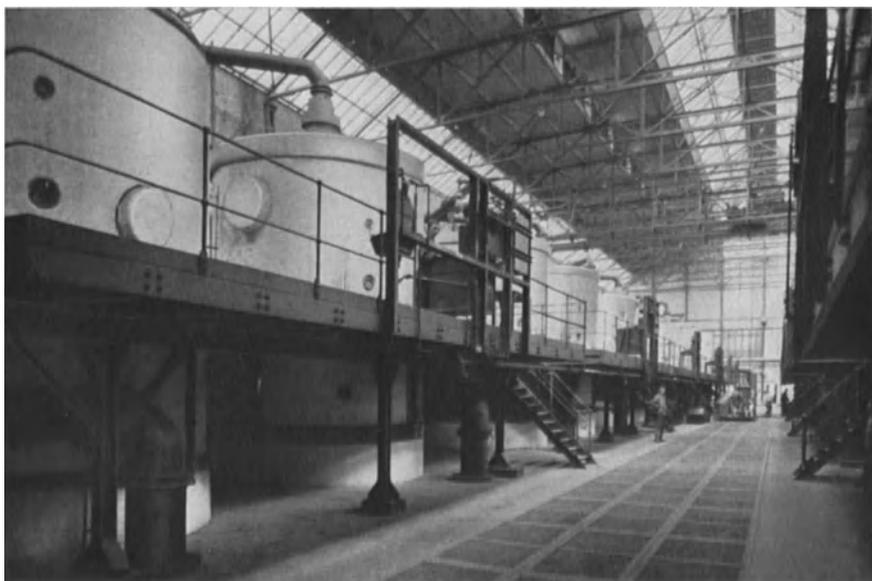
Abb. 181. Werk Oppau: Ammoniak-Oxydation, Kontaktöfen.
