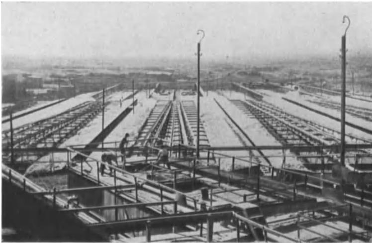
Abb. 166. Im Vordergrund die Behälter zum Klären der heiß gesättigten Nitratlösung, dahinter die Kühlkästen mit zum Trocknen seitlich aufgestapeltem Salpeter.
