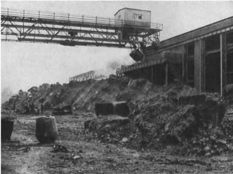
Abb. 113. Verladen der Schlacke in die Schlackenbunker.
