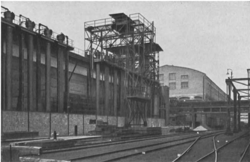
Abb. 138. Haber-Bosch-Verfahren: Kohlenoxydreinigung.
