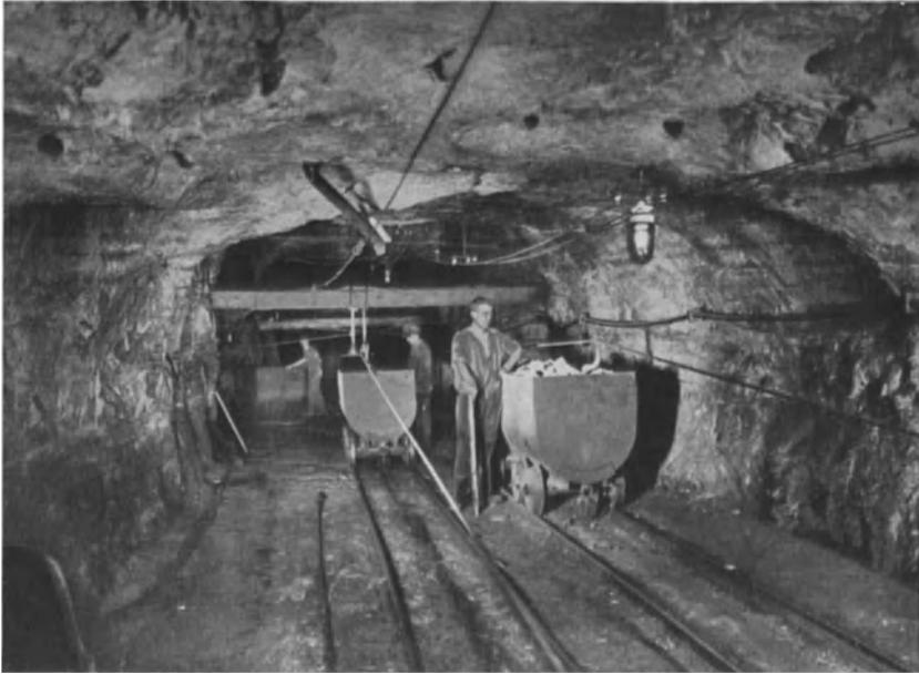
Abb. 65. Seilförderung. Transport der gefüllten Förderwagen zum Schacht.
