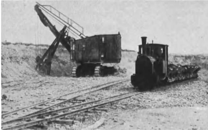
Abb. 82. Förderung des gelösten Gesteins durch Raupenband-Löffelbagger.
