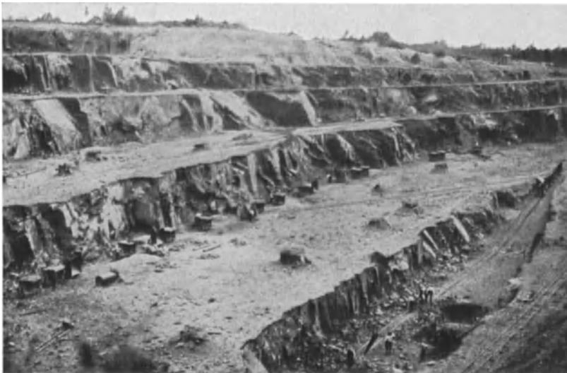
Abb. 80. Strossenbau. (Aus KLEHE, Das Kalkwerk. Berlin 1927. Aufn. Verein Deutscher Kalkwerke.)
