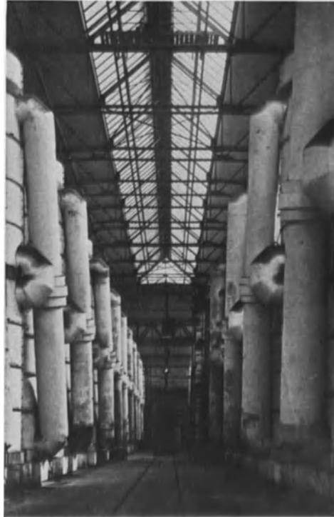
Abb. 135. Ammoniakwerk Merseburg: Kontaktwasserstoffanlage.
