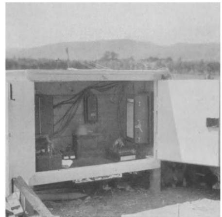
Abb. 205. Schutzschrank mit Registriergeräten.
