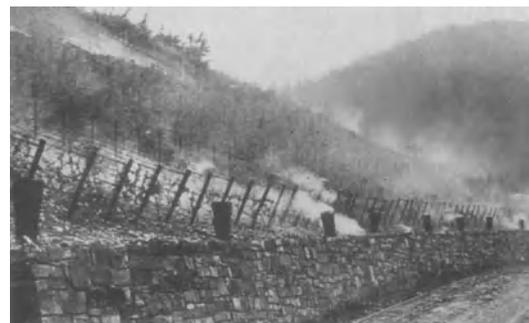
Abb. 198. Aufstellung der Brikettheizofen im Weinberg (kurz nach dem Anzünden).
