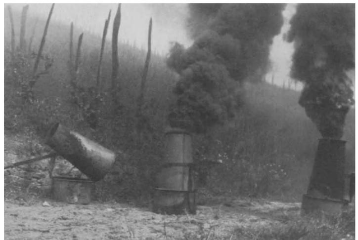
Abb. 190. Räucherapparat Maurer. Links außer Tätigkeit — Mitte auf Rauchwirkung — rechts auf Heizung eingestellt. (Ahrweiler 1930).
