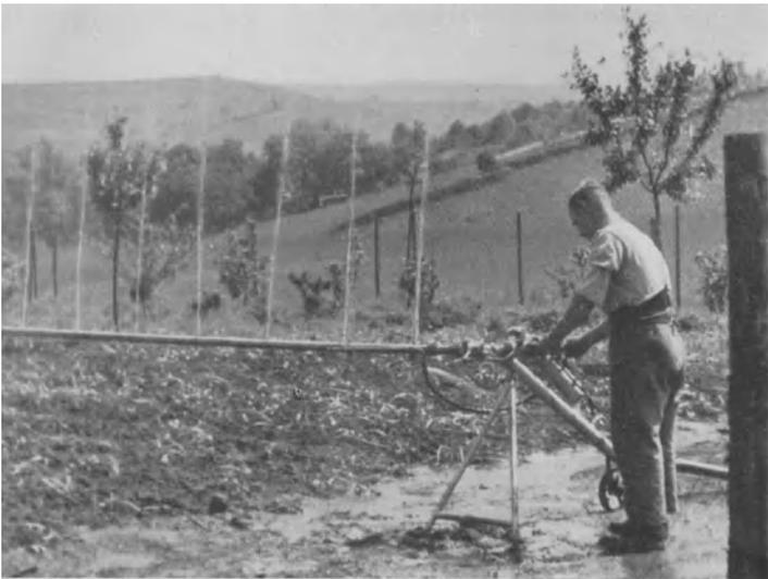
Abb. 201. Schwenkregner „Hydor“ in Tätigkeit.
