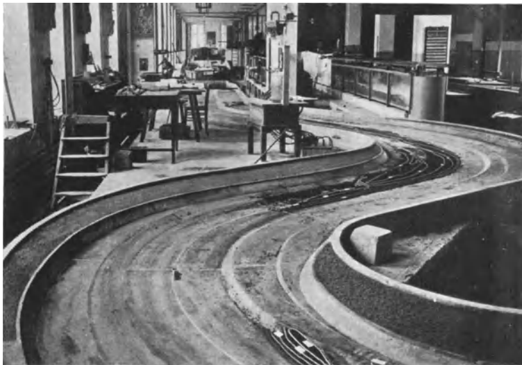
Abb. 20. Verlandung der Vorländer bei der Form C durch Geschiebewanderung.
