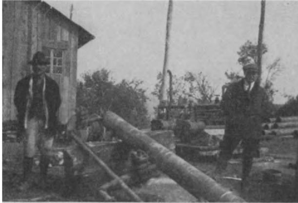
Abb. 43. Zementierung nach Perkins in Moreni (Rumänien). Vorn Zementierkopf, im Hintergrunde die Pumpen zum Einpressen des Zementes.
