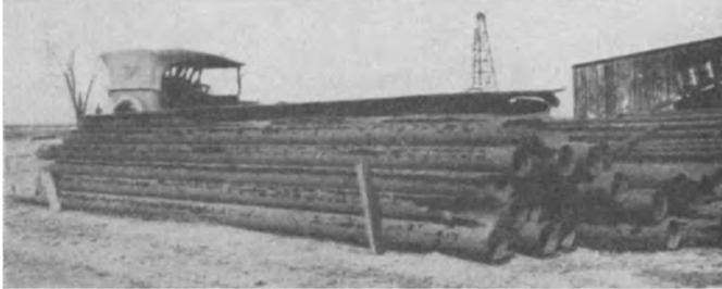
Abb. 17. Der Länge nach korrodierte Bohrröhre nach zweijährigem Gebrauch.
