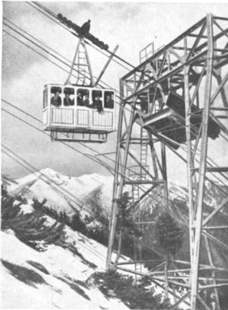
Abb. 11. Raxbahn. Portalstütze
