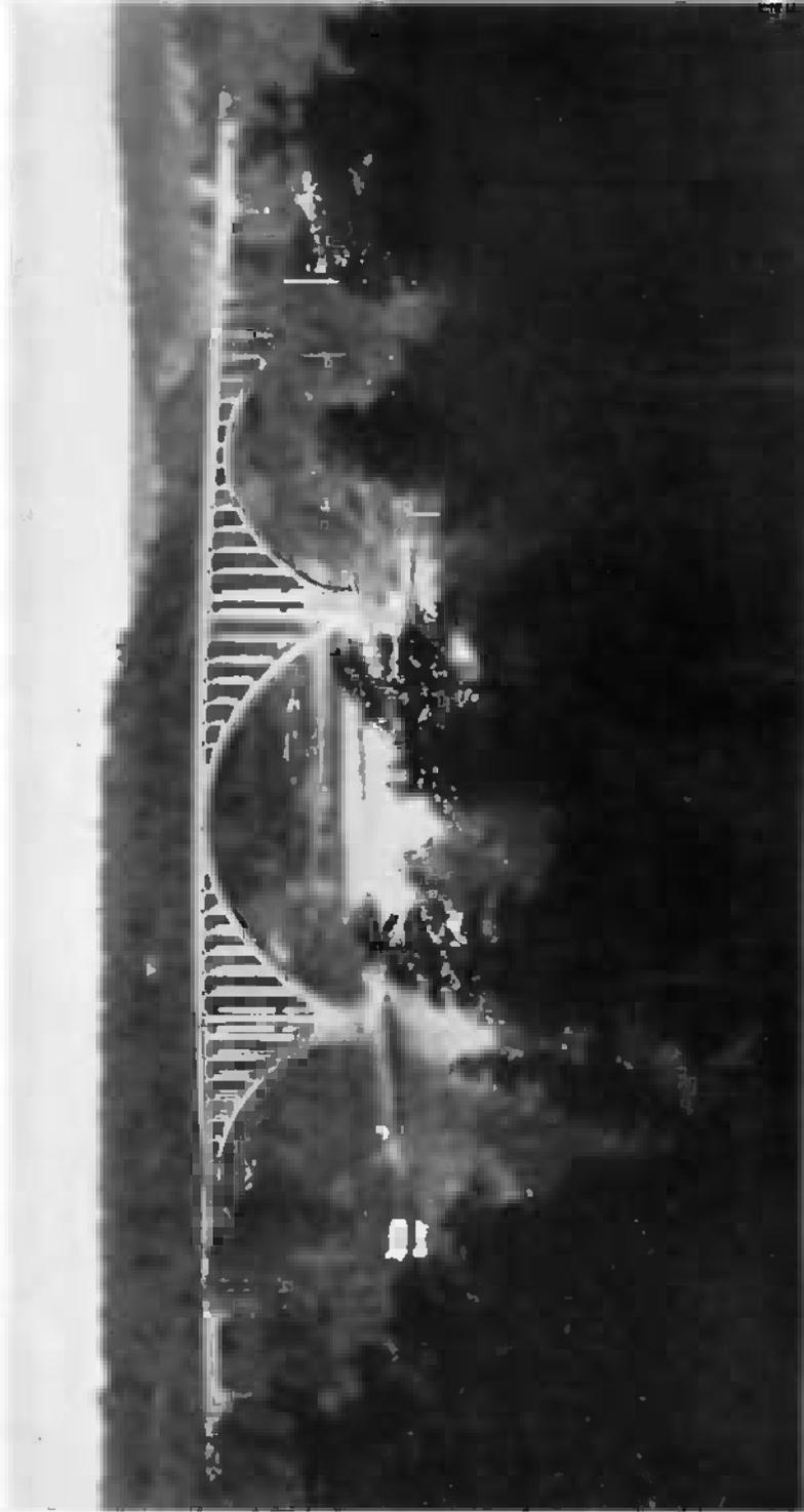
Abb. 30. Landstraßenbrücke über den Skuru-Sund bei Stockholm. Das massive Geländer verrückt die Silhouettenwirkung der Brücke. Sie wirkt optisch als breiter Balken, durch dünne Stäbbögen abgesteift. Es sind zu viele Konstruktionselemente: die Zwischenpfeiler stehen zu dicht aneinander; der Mittelbogen ist am besten, aber die Seitenbögen sind unschön und hätten besser durch gerade Balken ersetzt werden können
