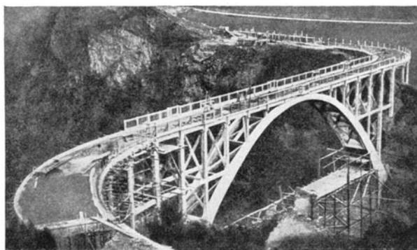
Fig. 48. Viaduct d'*Exiles* sur le *Doria Riparia*. Arcs encastrés: ouvert. m 60,00; flèche m 19,70
