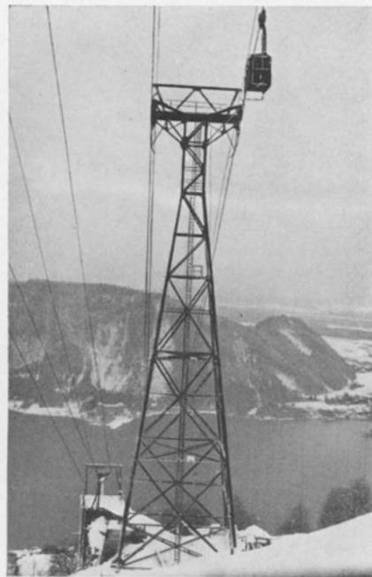
Abb. 9. 39 m hohe Stütze der Kanzelbahn am Ossiachersee
