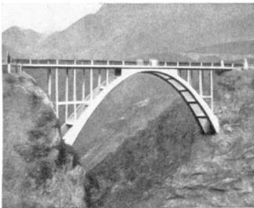
Fig. 44. Pont de *Cremenno*. Arcs encastrés: ouvert. m 53,50; flèche m 19,75
