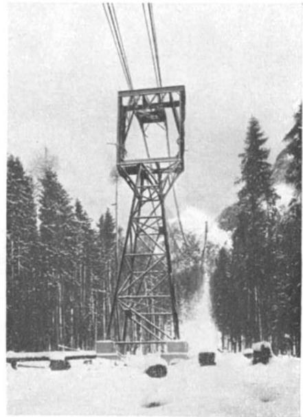
Abb. 12. Ehrwald—Zugspitze. Stütze mit Pyramidenrumpf und Portalkopf
