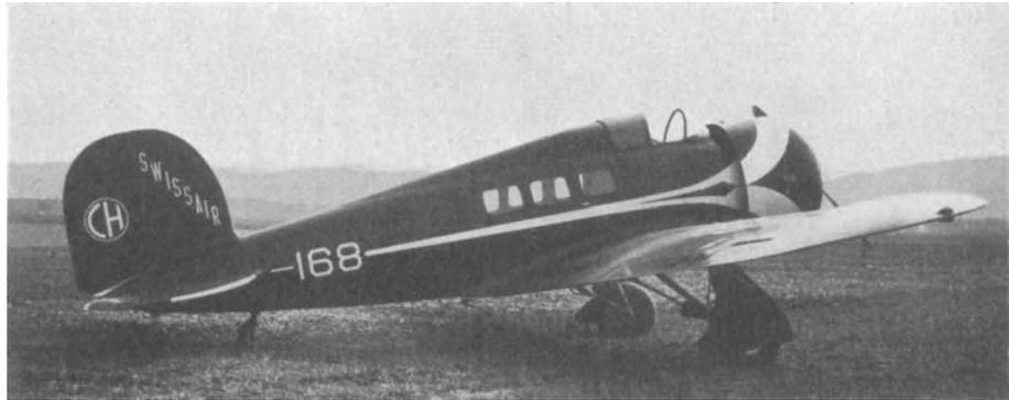
Abb. 14. Aerodynamisch günstig ausgebildetes Flugzeug (Lockheed Orion)
