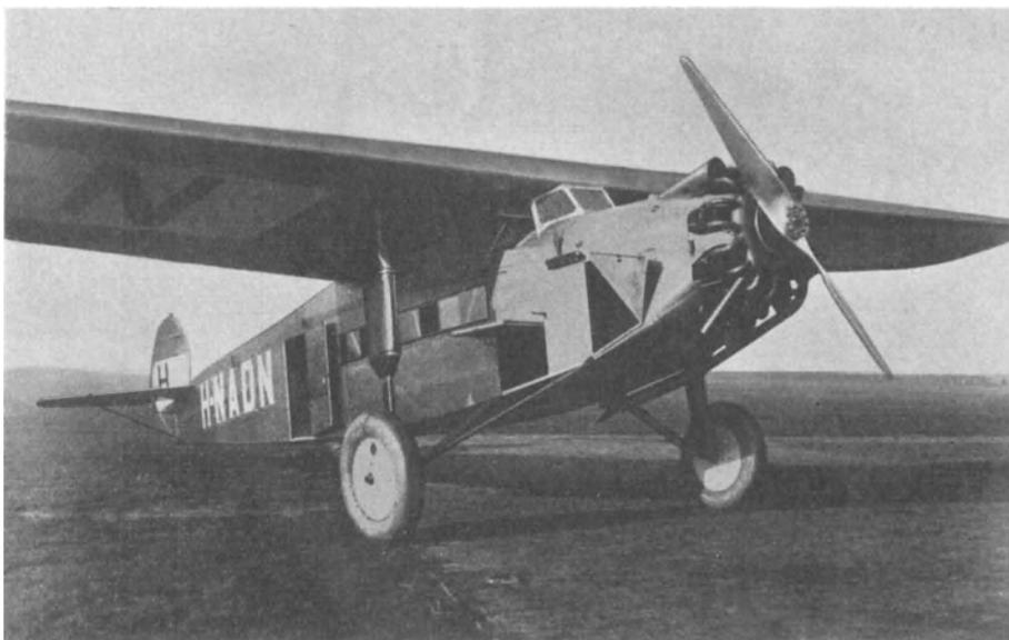
Abb. 13. Aerodynamisch ungünstig ausgebildetes Flugzeug
