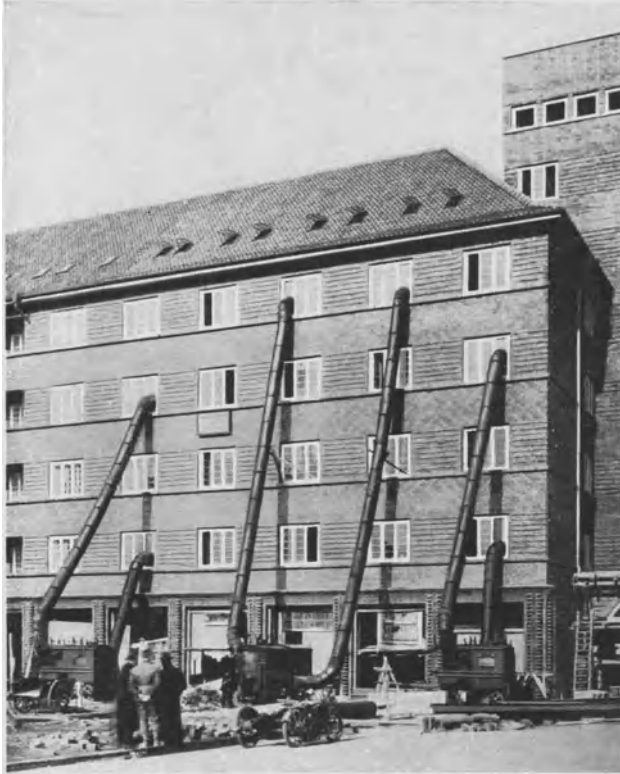
Abb. 91. Drucklufttrockenverfahren (Deutsche Bautrocknungs-Ges. m. b. H., Hannover-Hainholz).
