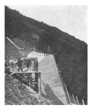
Abb. 165. Stützmauer aus Beton.
