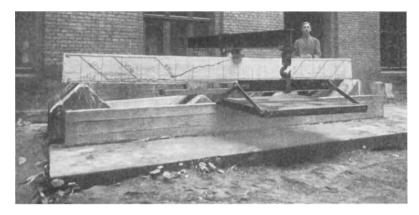
Abb. 95. Biegeversuch an Eisenbetonbalken.
