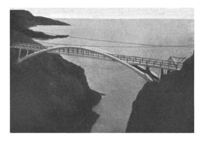
Abb. 200. Bogenbrücke mit teilweise angehängter Fahrbahn.
