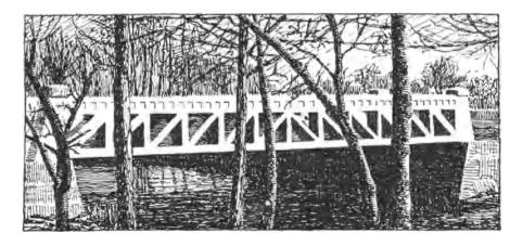
Abb. 207. Visintini-Träger über der Fahrbahn.
