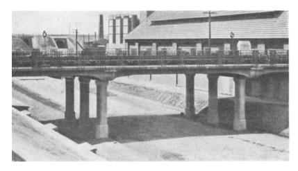
Abb. 344. Durchlaufender Balken.
