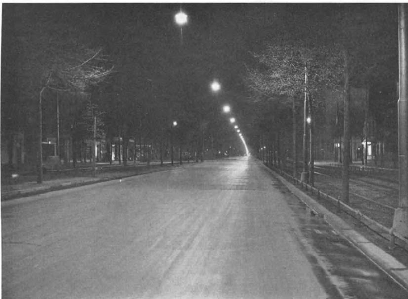
Abb. 960. Beleuchtung der Bismarckstraße in Berlin. Leuchten mit Opalglaszylinder in Mittelaufhängung. Lichtpunktabstand 30 m, Lichtpunkthöhe 9 m. Quecksilberdampf lampen. (Siemens-Schuckert-Werke A.G., Berlin.)
