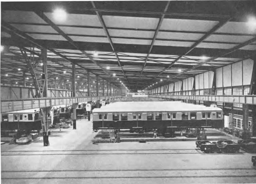
Abb. 743. Hohe Werkshalle, beleuchtet durch Tiefstrahler über der Kranbahn. (Aus Siemens-Z. 1929.)
