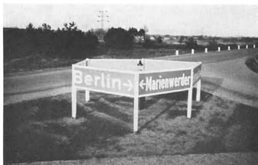
Abb. 975. Sechseck-Transparentschild zur Kennzeichnung der Zufahrtstellen zur Autobahn, beleuchtet durch Propan-Gasleuchte mit Gürtellinse. Tagesaufnahme. (J. Pintsch K.G., Berlin.)
