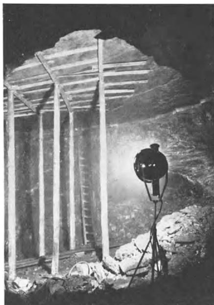
Abb. 836. Flutleuchte für Abbau. Bild: SSW.
