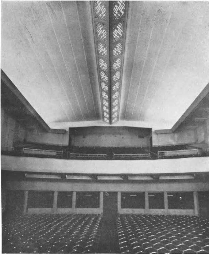
Abb. 774. Indirekte Beleuchtung eines Zuschauerraumes mit Leuchtorndament.
