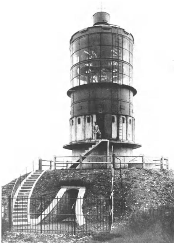
Abb. 1132. Feuer auf dem Mont Afrique bei Dijon. Höhe des Gebäudes 12 m, Durchmesser 5,5 m. 1 Milliarde K. Größtes Flugfeuer der Welt.
