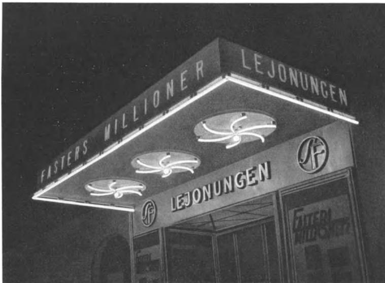
Abb. 765. Beleuchtung eines Kinoeinganges durch Linestraröhren.
