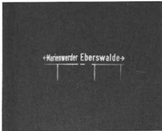
Abb. 976. Sechseck-Transparentschild zur Kennzeichnung der Zufahrtstellen zur Autobahn, beleuchtet durch Propan-Gasleuchte mit Gürtellinse. Nachtaufnahme. (J. Pintsch K.G., Berlin.)
