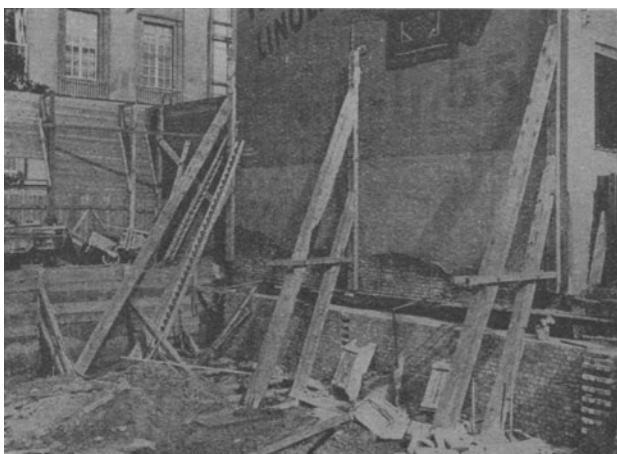
Abb. 4. Absteifung eines 11-m-Giebels. Dieser ist bereits abschnittsweise unterfahren und der Neubausoekel schon hochgeführt worden.
