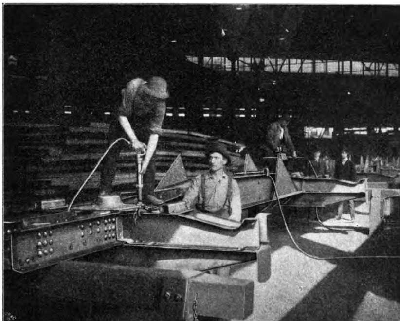
Fig. 192. Nieten mit Druckluft auf einer Werft.
