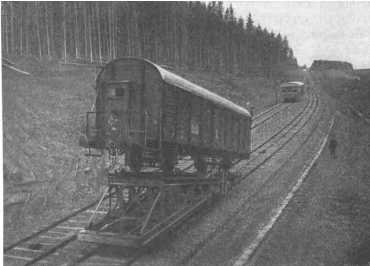
Abb. 157. Schrägaufzug (Bergbahn) mit Seilbetrieb für Personen- und Güterbeförderung (Heckel).
