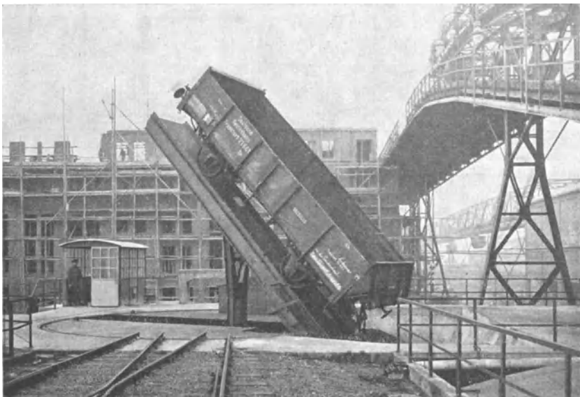
Abb. 133. Wagenkipper auf Drehscheibe (Pohlig).
