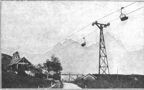
Abb. 154. Einseilbahn zur Beförderung von Mergel (Bleichert).
