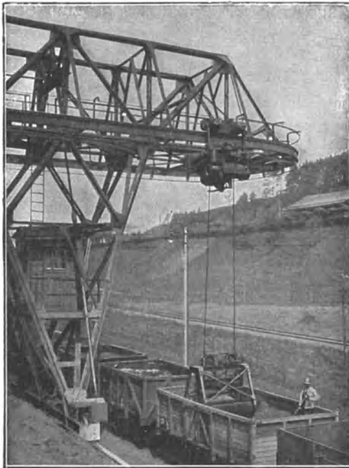
Abb. 189. Elektrowindenbahn mit Selbstgreiferbetrieb zum Entladen von Eisenbahnwagen (Bleichert).
