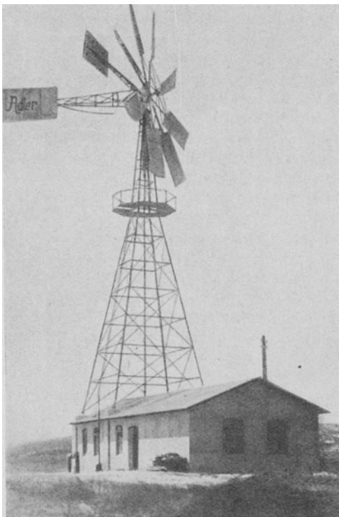
Abb. 8. Wind-Elektro-Anlage mit 15 kW Gleichstrom-generator, Akkumulatorenbatterie und Reservediesel, Turmhöhe 20 m (errichtet von der Firma Köster, Heide/Holstein).
