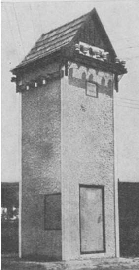
Abb. 30. Ortsnetztransformatorstation (20 kV/380/220 Volt).
