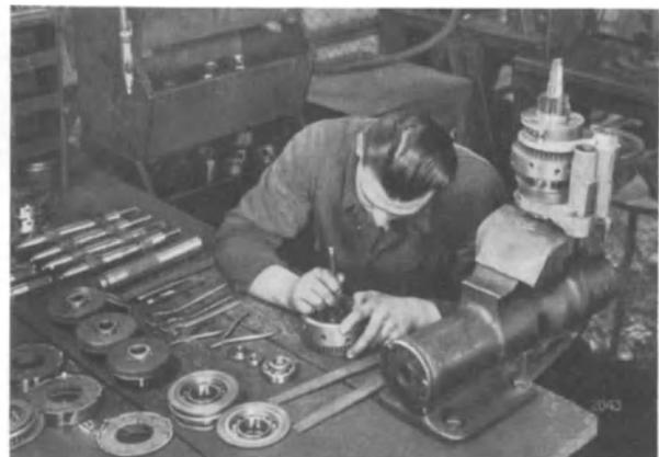
*Bild 910: Nach der Schlußprüfung in den mechanischen Werkstätten werden die Einzelteile am Bereitstellungsplatz gesammelt; von hier gelangen sie zum Zusammenbau der Einheiten.*
