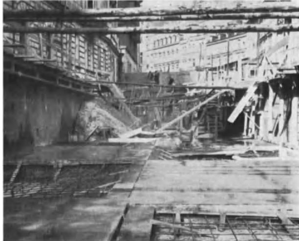
Abb. 45. Herstellung der Dichtungsplatte über den Herdmauern aus armiertem Beton.
