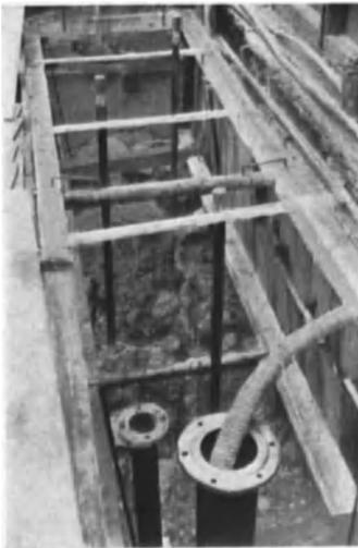
Abb. 44. Dichtungsarbeiten im Bette des Teplflusses, Karlsbad. Das Rohr im Vordergrund dient der Wasserhaltung. Die Stein-draine auf der Sohle führen ihm das Wasser zu. Die schwächeren Standrohre dienen zur Ableitung des Kohlensäuregases während des Betonierens und späterem Einpressen des Injektionsgutes. Die Zimmerung wird mit fortschreitender Betonausfüllung gezogen.
