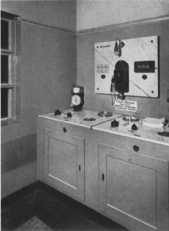
Abb. 156. Regulierpult für pneumatische Kammern.
