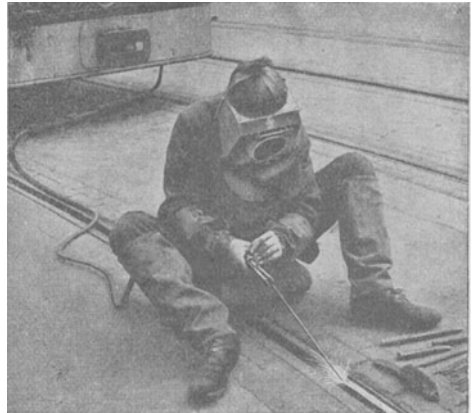
Abb. 159. Schweißer mit Schweißgerät (beim Schienenaufschweißen).
