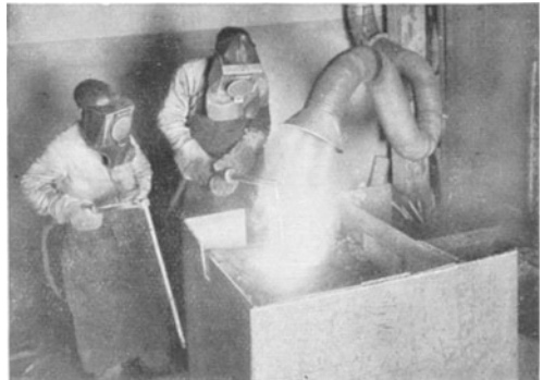
Abb. 312. Elektrische Warmschweißung eines Maschinenständers.
