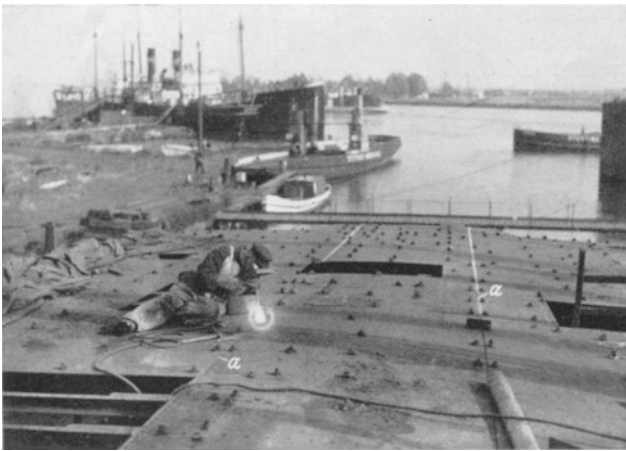
Abb. 272. Schweißen am Deck eines Spülers.
