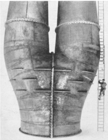
Abb. 208. Hosenrohrformstück für eine Turbine.
