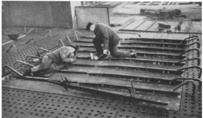
Abb. 274. Schweißen eines Schotts auf der Spannplatte.
