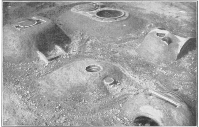
Abb. 314. Zur Wärmeschweißung vorbereitete Gußstücke.
