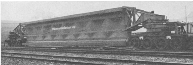
Abb. 291. Geschweißte Vollwandbrücke.
