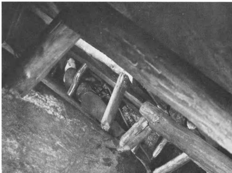
Abb. 18. Arbeiten mit dem Abbauhammer bei schwieriger Lagerung in einem dünnen Flöz.
