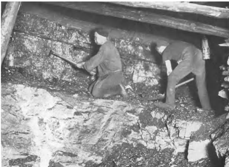
Abb. 13. Typische Arbeiten des Kohlenhauers (Kohlegewinnung mit der Hacke, Handarbeit) und des Lehrhauers (Schaufeln), Benzinhandlampe.
