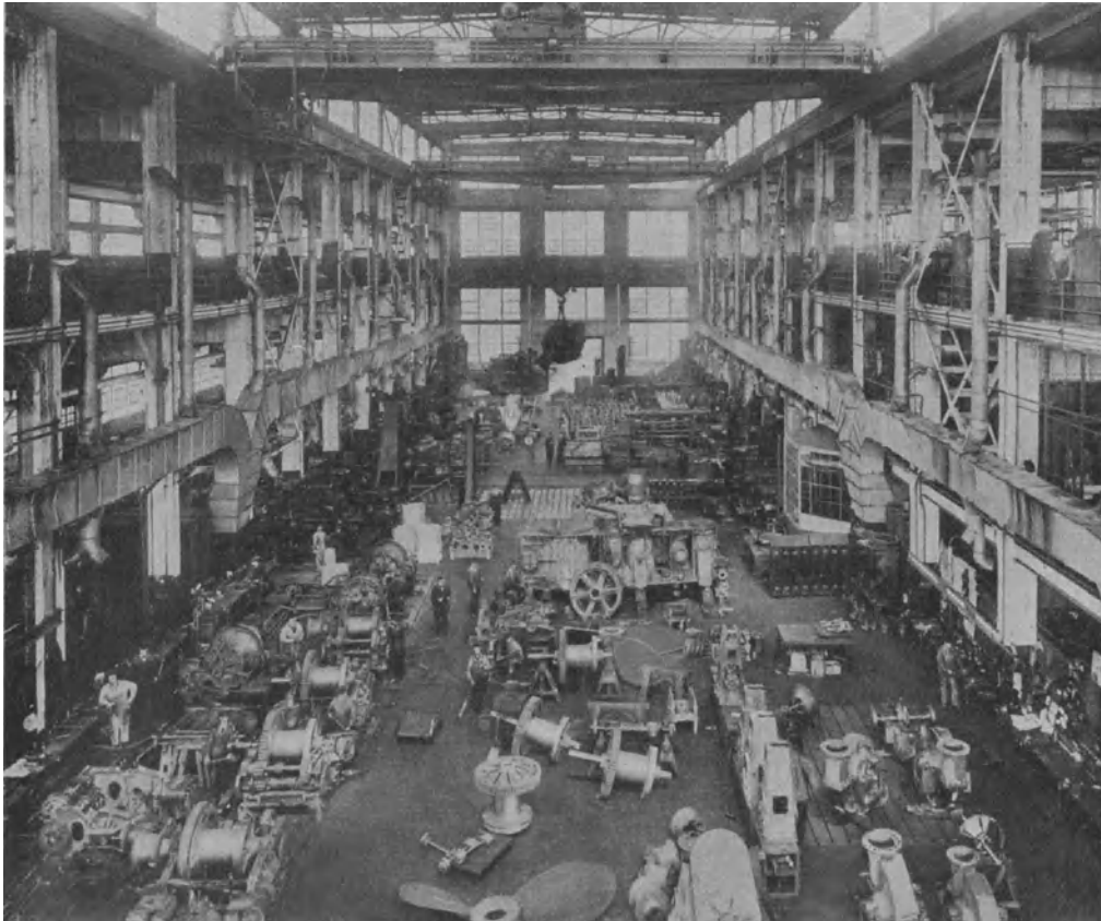
Abb. 88. Maschinenbauhalle der Moore Plant Bethlehem Shipbuilding Corp. in Elizabethport.
