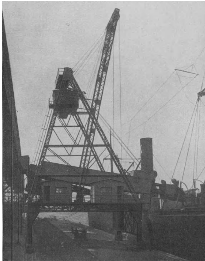
Abb. 120 a. Schiffsbekohlungsanlage Dairen. Fahrbarer Verladeturm mit Teleskop-Förderband in Arbeitsstellung bei einer Schiffsbekohlungs.
