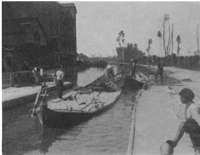
Abb. 143. Torre del Mangano: 2 Schuten werden aus dem geöffneten Oberhaupt der 450 Jahre alten Schleuse herausgetreidelt.
