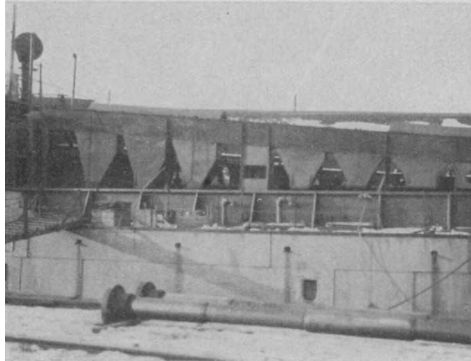
Abb. 97. Kohlendampfer, Einzelheiten der Ladeluken.
