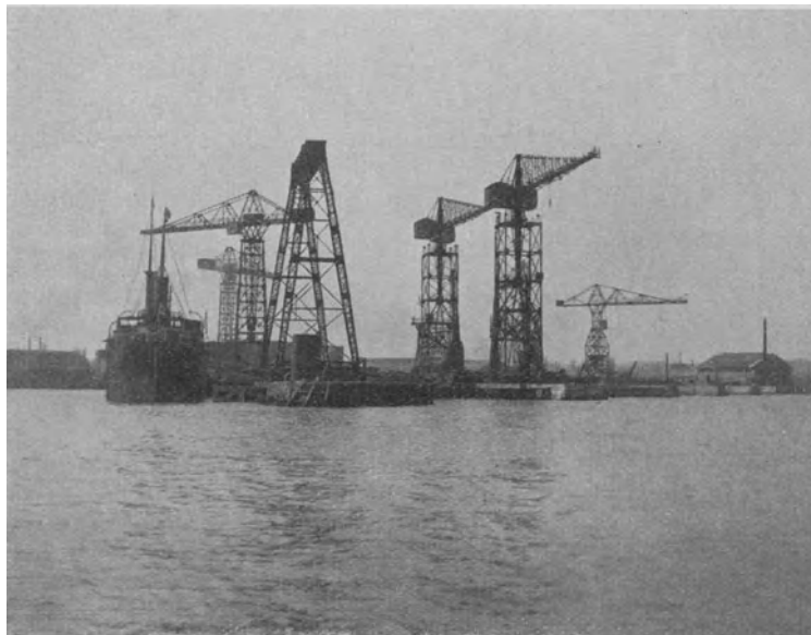
Abb. 117. Yokohama: Asano-Schiffswerft, Hellingkrane.
