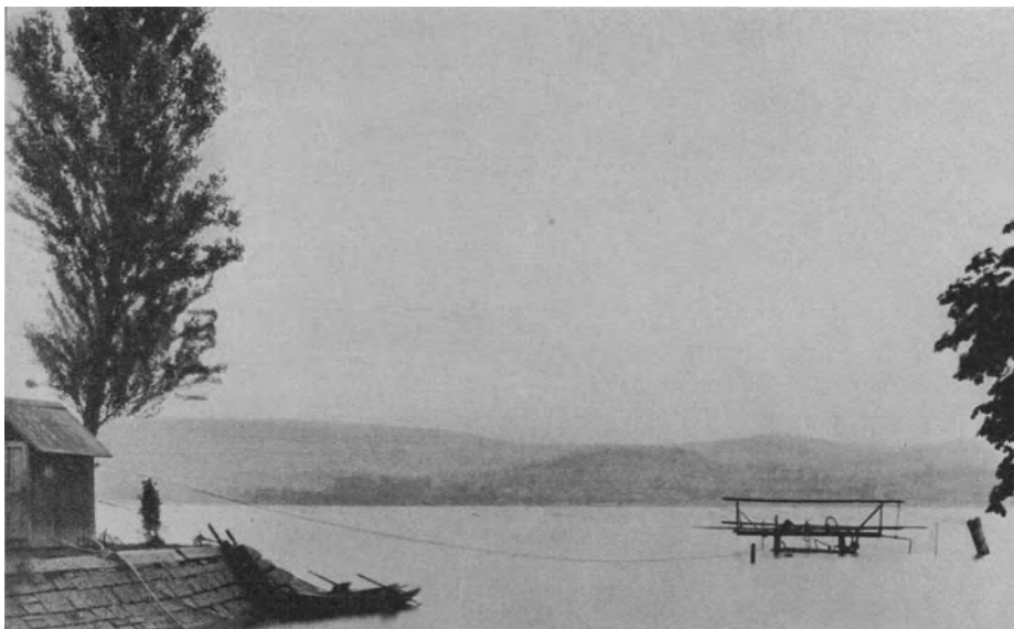
Abb. 15. Anlage während des Versenkens in den Zürichsee.
