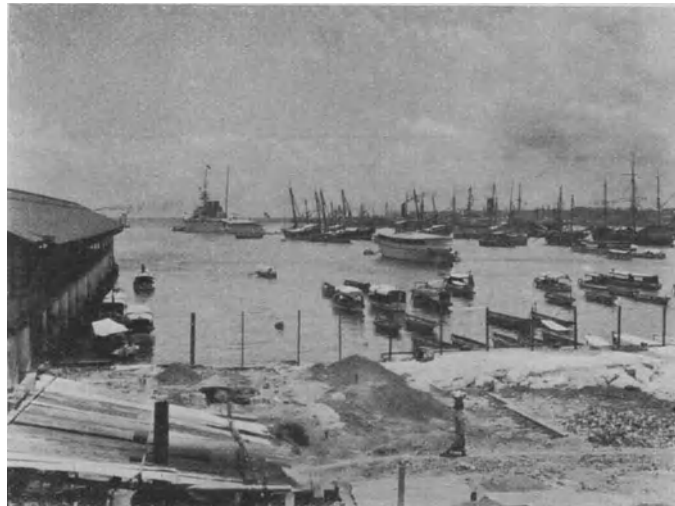
Abb. 138. Colombo: Hafen, Teilansicht von Ausschachtungsarbeiten.
