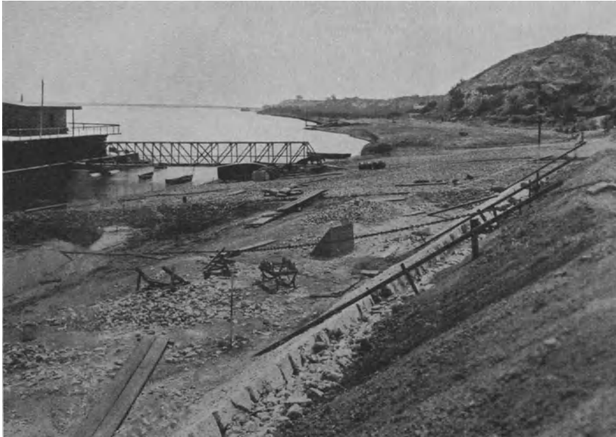
Abb. 13. Hafen von Fernandrias: Uferbefestigung und schwimmende Anlegebrücke aus Eisenbeton.
