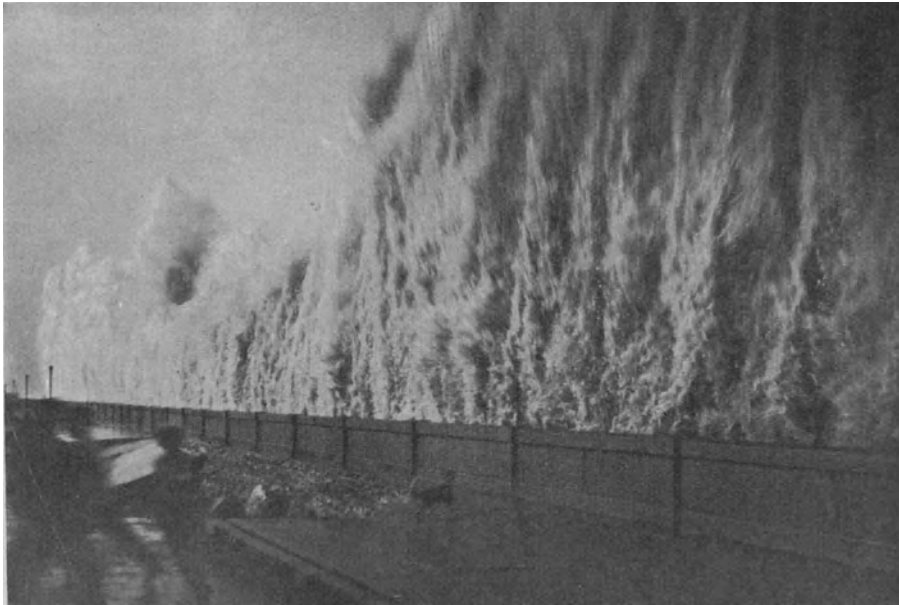
Abb. 58. Zerstörung der Ufermauern in Rio de Janeiro durch eine Resaca (Sturzsee).
