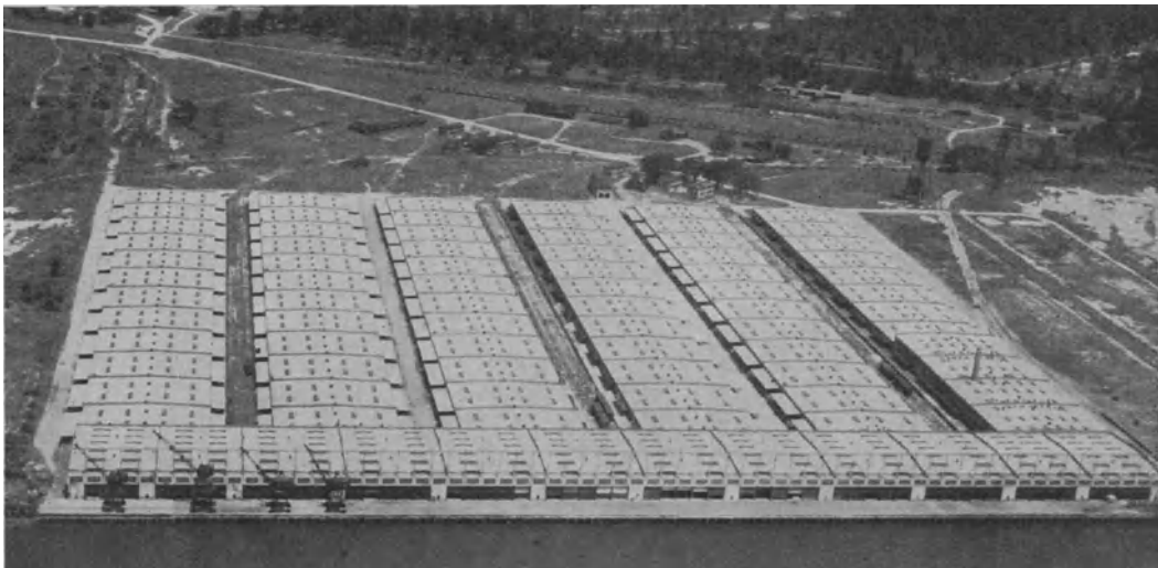
Abb. 71. Neue Schuppenanlage des Hafenamtes von Charleston (South Carolina).
