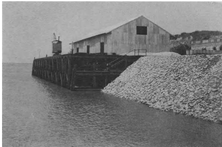
Abb. 12. Molenbau aus Steinholz in dem kleinen Paranahafen Uruquiza.
