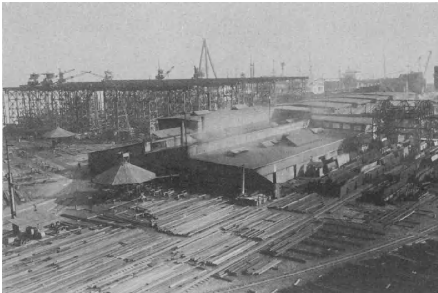
Abb. 111. Bethlehem Shipbuilding Co. Union Plant Potrero-Werk Helling Krawe (vorn rechts der Eisenlagerkran).
