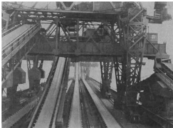
Abb. 74. Kohlenpier mit Förderbänken.
