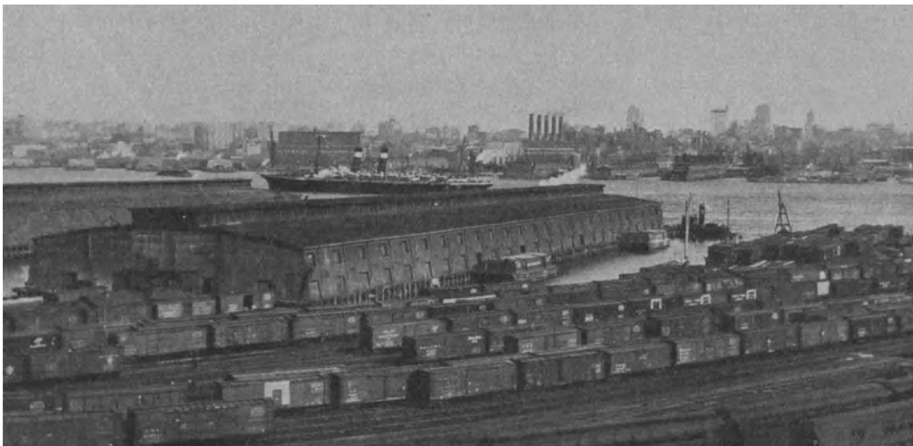
Abb. 81. Die typischen gedeckten Piers mit Leichter und Eisenbahnbetrieb in New Jersey.
