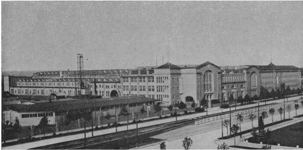
Abb. 4. Das Dynamowerk der Siemens-Schuckertwerke.
