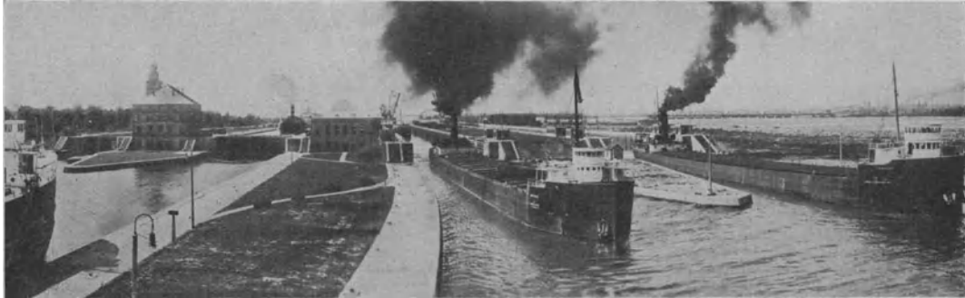
Abb. 103. Die 4 Schleusen der Ste. Maurice Falls (Mich.). Zwischen Oberem und Huron-See.
