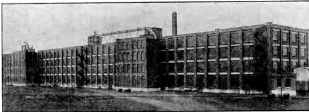
Abb. 40. Außenansicht des vierstöckigen Werkstättengebäudes der Singer Manufacturing Co., Wittenberge, Abb. 39. (Aus W. T. 1913, S. 577, W. Franz. Q. 205.)
