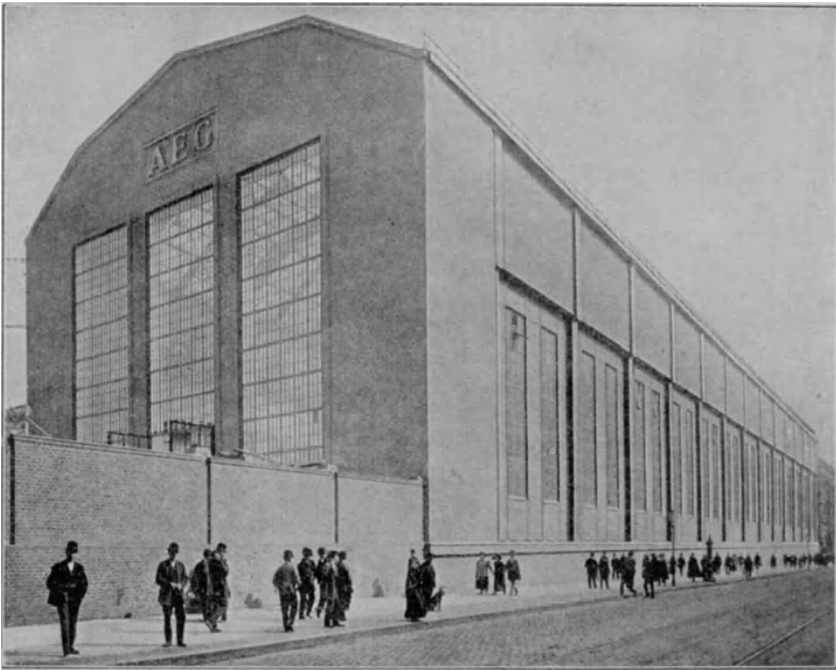
Abb. 271. Außenansicht der Großmaschinenbauhalle der A.E.G. Berlin, Werk Hussitenstraße. (Aus Z. 1913, S. 1200. Q. 116.)
