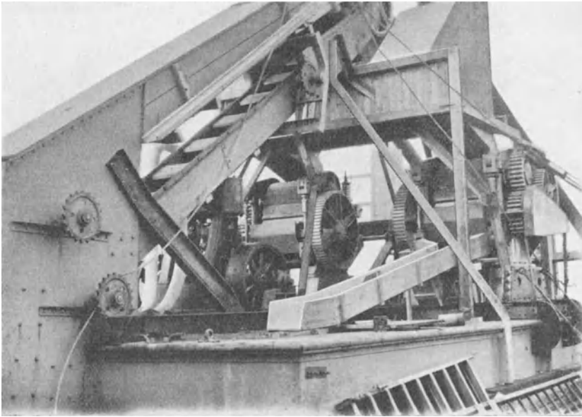
Abb. 361. Walspeckpressen an Bord eines Kochereischiffes.
