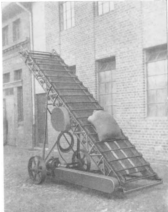
Abb. 51. Fahrbarer und in der Höhe verstellbarer Sackstapler mit elektromotorischem Antrieb. (Georg Becker u. Co., Magdeburg-Sudenburg.)
