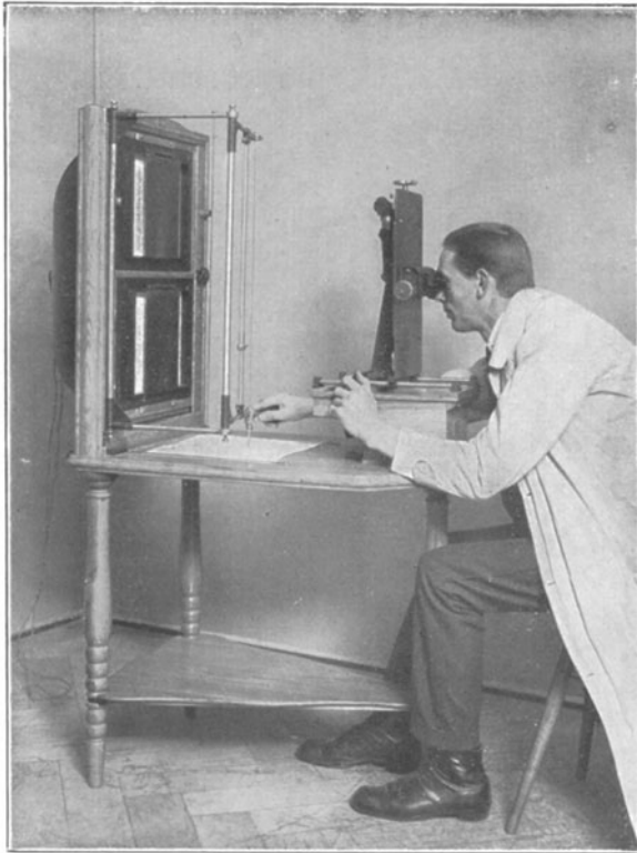
Abb. 28. Röntgen-Stereoorthodiagraph nach BEYERLEN der „Röntgen-Stereo-Beyerlen“, München, Mandlstr. 1d.
