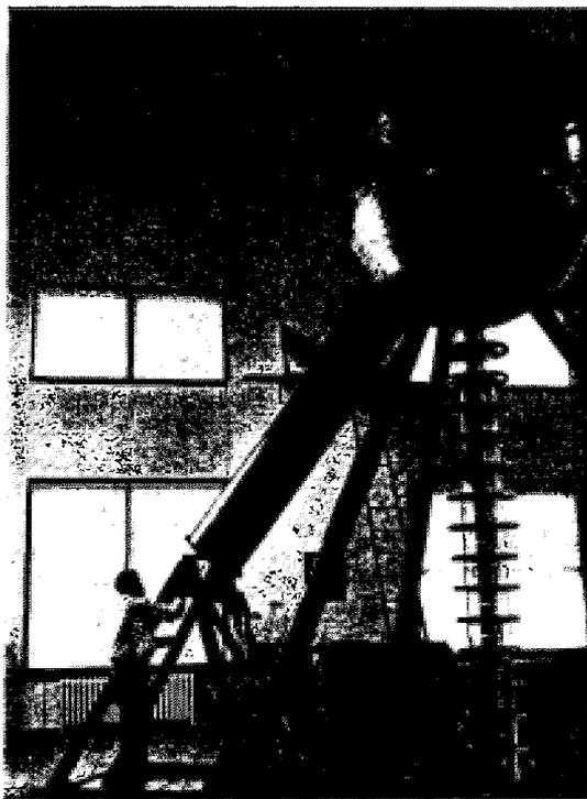
Abb. 26. Bandgenerator von TUVE, HAFSTAD und DAHL mit Entladungsröhre für 1,2 MV bei einem Kugeldurchmesser von 2 m. In dem linken Rohr auf dem Gestell befindet sich der Hochohmwiderstand zur Spannungsmessung.
