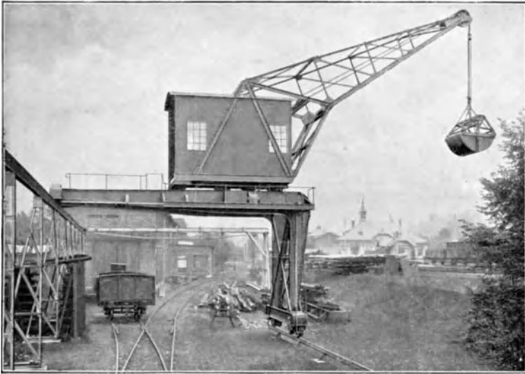
Fig. 31. Semi-gantry crane
