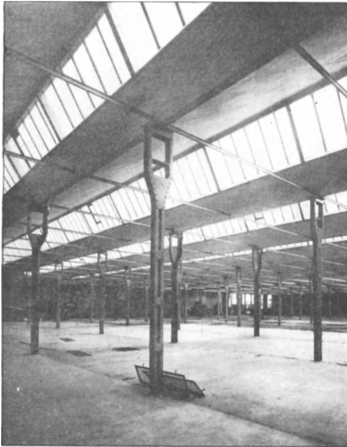
Abb. 168. Flachsaaubau mit Sägedach; Stützen zum Durchziehen von Wellenleitungen eingerichtet. (Aus W. T. 1913, S. 288, W. Franz. Q. 202.)
