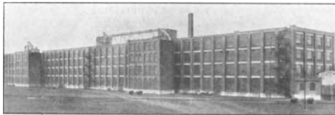
Abb. 35. Außenansicht des vierstöckigen Werkstättegebäudes der Singer Manufacturing Co., Wittenberge, Abb. 33. (Aus W.T. 1913, S. 577, W. Franz. Q. 205.)
