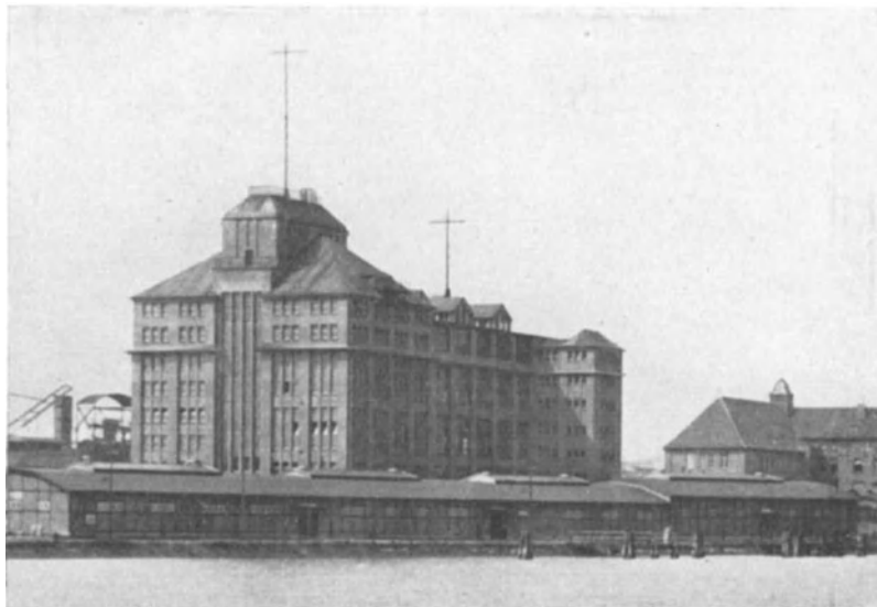
Abb. 218b. Mechanikerwerkstatt (für Eltanlagen und Funkentelegraphie) des Unterseebootressorts der Reichswert Wilhelmshaven. 4 Hauptgeschosse; im Südteil des Kopfbaues außerdem 4 Zwischengeschosse. Inneres siehe Abb. 13.
