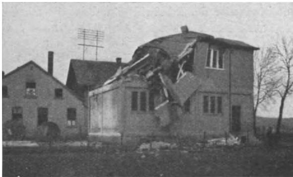
Abb. 7. Wiederholtes Einschalten auf schweren Kurzschluß.
