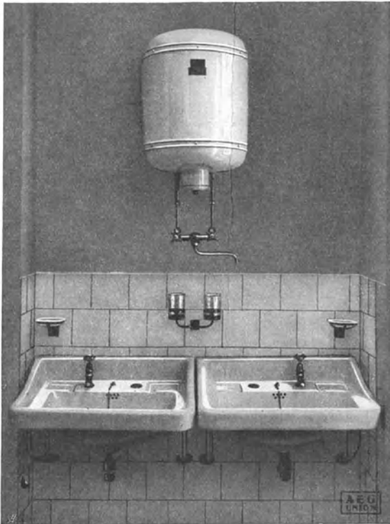
Abb. 28. Mischbatterie mit schwenkbarem Auslauf am Heißwasserspeicher über 2 Waschbecken.
