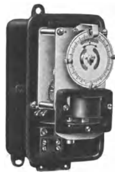
Abb. 72. Schaltuhr mit elektrischem Aufzug und Verstellung der Schaltzeiten von außen.
