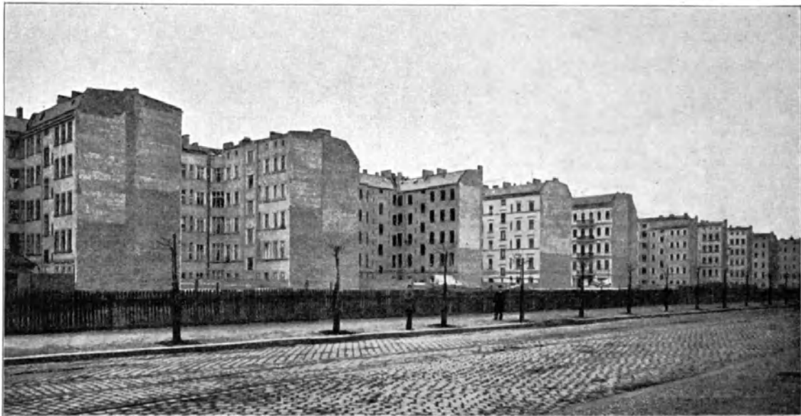
Hinteransicht einer Miethshäuserreihe in Moabit, erbaut im Jahre 1895.
