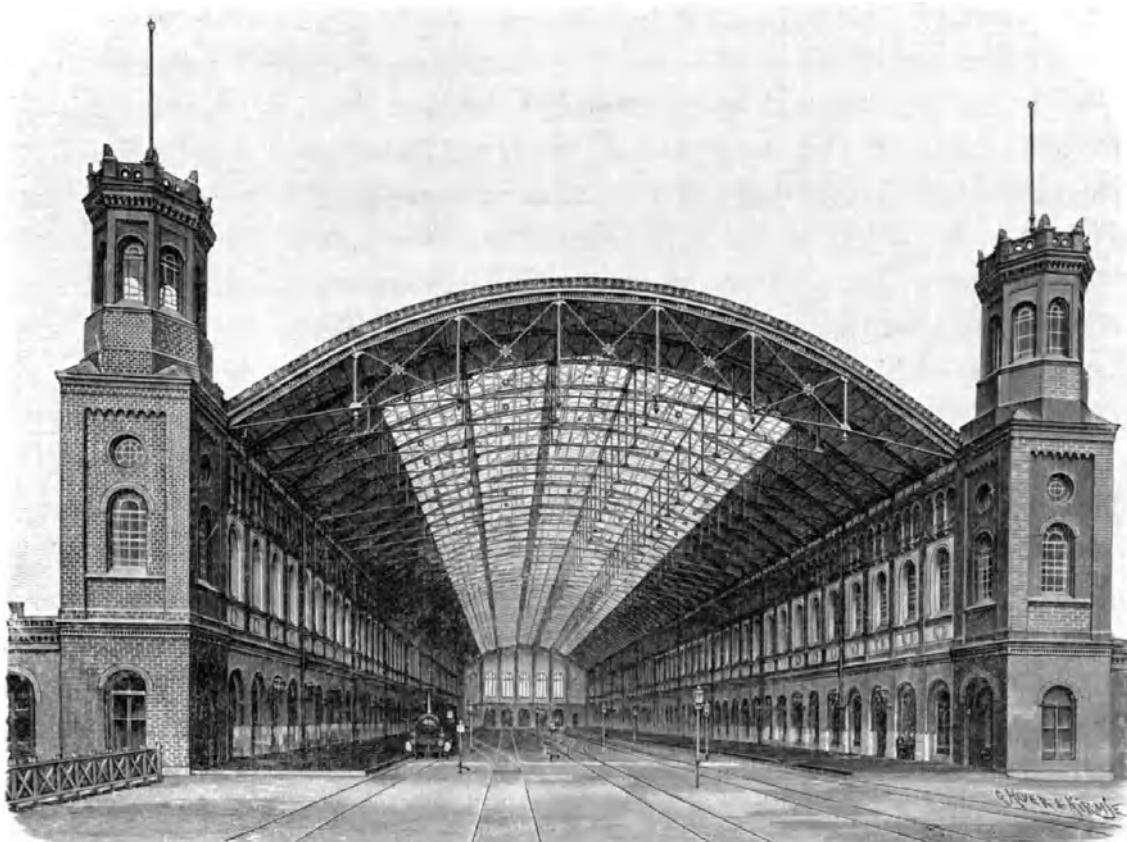
Oestliche Giebelansicht der Bahnsteighalle des Niederschlesisch-Märkischen Bahnhofs nach dem ersten Umbau im Jahre 1869, mit Schienenübergang im Zuge der Fruchtstrasse.
