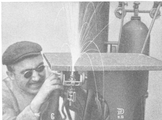
Abb. 298. Überkopfschneiden.
