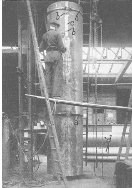
Abb. 225. Doppelseitiges Schweißen einer stehenden Naht.
