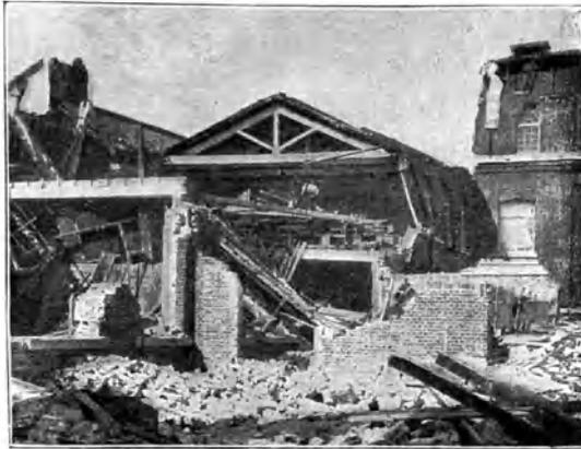
Ein durch das Mino-Dwari-Beben zerstörtes Steingebäude, nach europäischem Muster gebaut.
