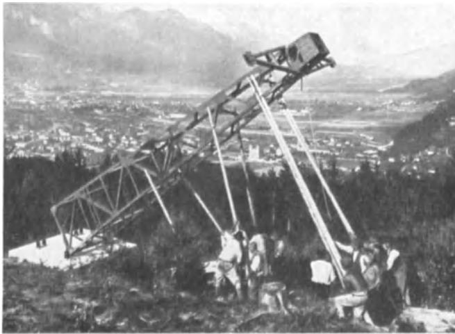
Abb. 436. Aufkippen eines Eisengittermastes.
