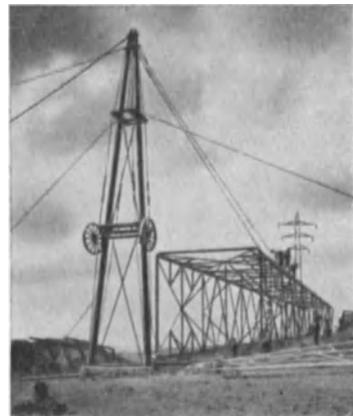
Abb. 440. Aufkippen mittels Hilfsbockes. (S. S. W.)
