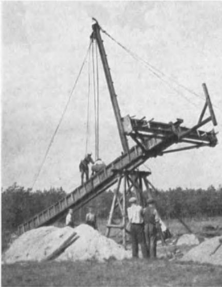
Abb. 452. Anheben einer Meeg-Mastschalung.
