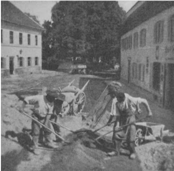
Abb. 19. Handmischen des Betons nach süddeutscher Art.
