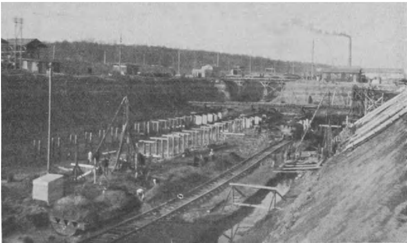
Abb. 2 u. 3. Schiebebühnen für Betontransport zu einer großen Fundamentplatte.
