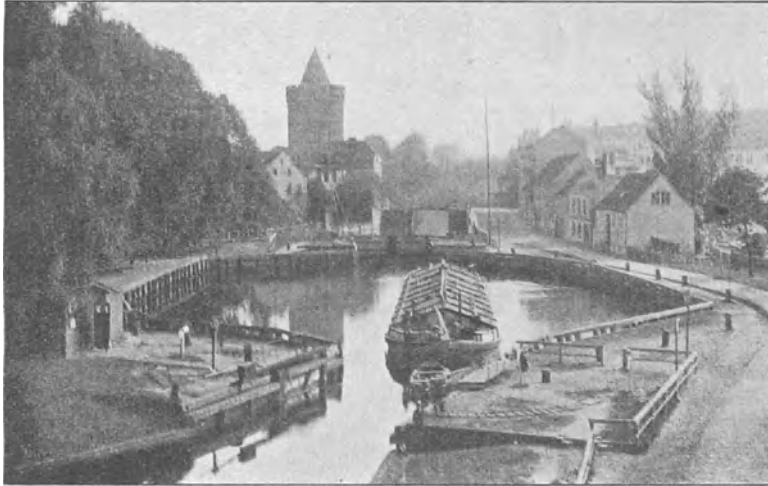
Abb. 16. Stadtschleuse in Brandenburg a./H.
