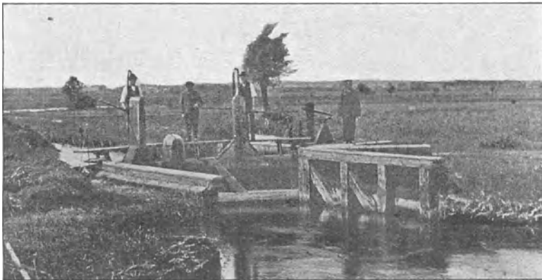
Abb. 1. Stauschleuse bei Wesenberg (Mecklenburg).
