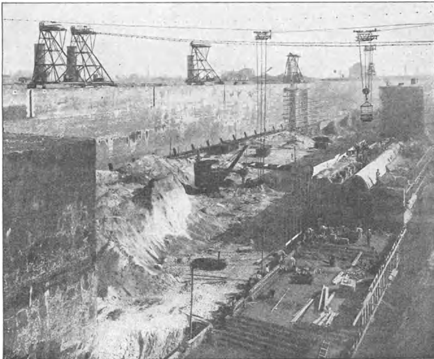
Abb. 47. Bodenaushub und Betonarbeiten an den Schleusen bei Holtenau mit Hilfe von Pohlig-Kabelkranen.
