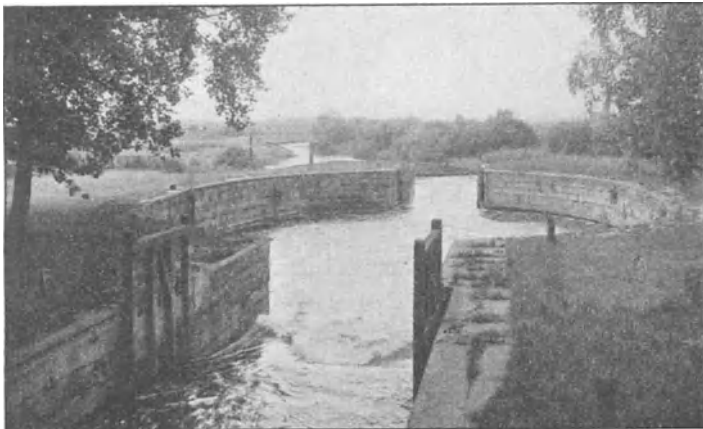
Abb. 17. Palmschleuse bei Lauenburg.
