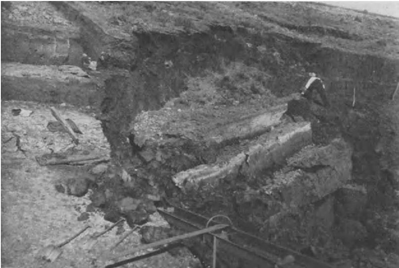
Abb. 23. Abrutschen des Püttenrandes infolge Entwässerung.
