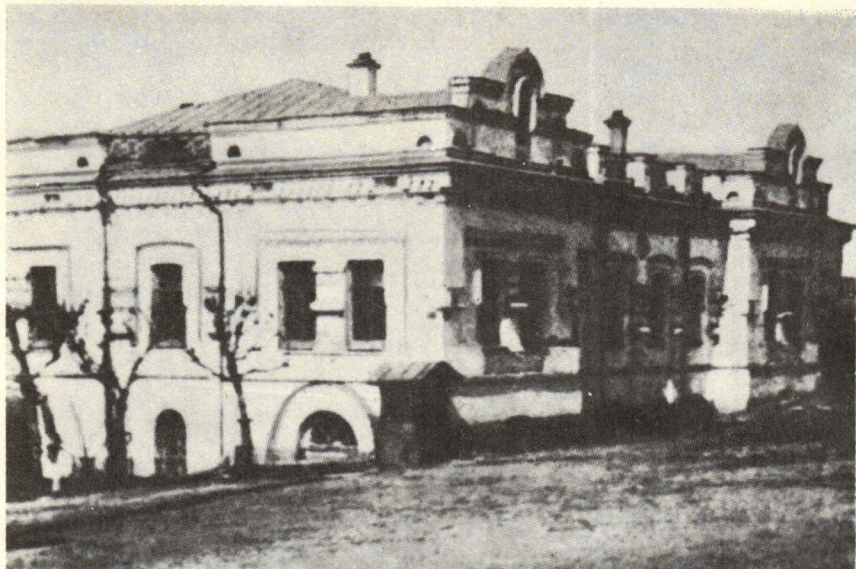
21. Дом Ипатьева, где была убита в Екатеринбурге царская семья (с угла Вознесенского просп. и Вознесенского переулка).
