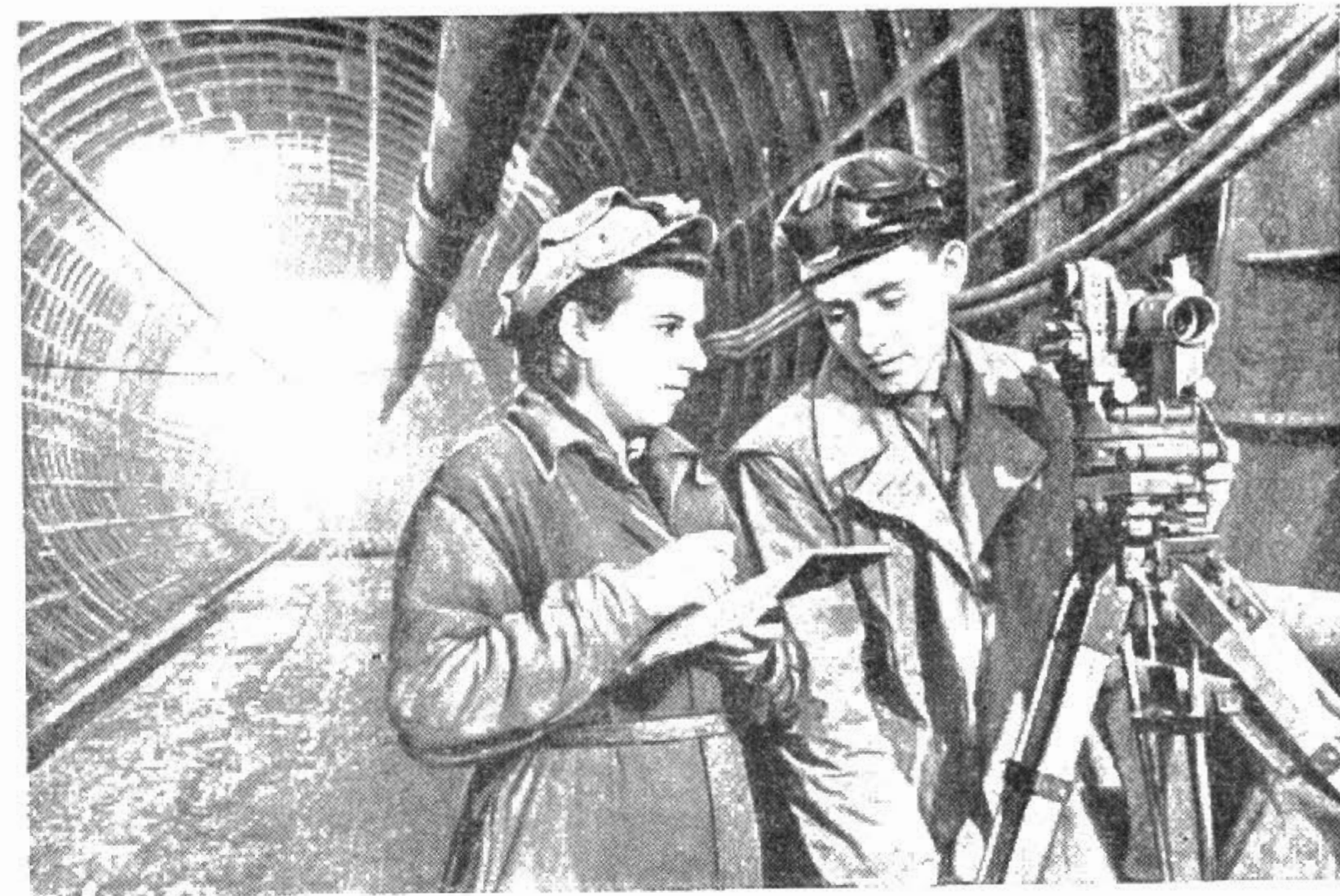
На строительстве метро. В новом тоннеле.
