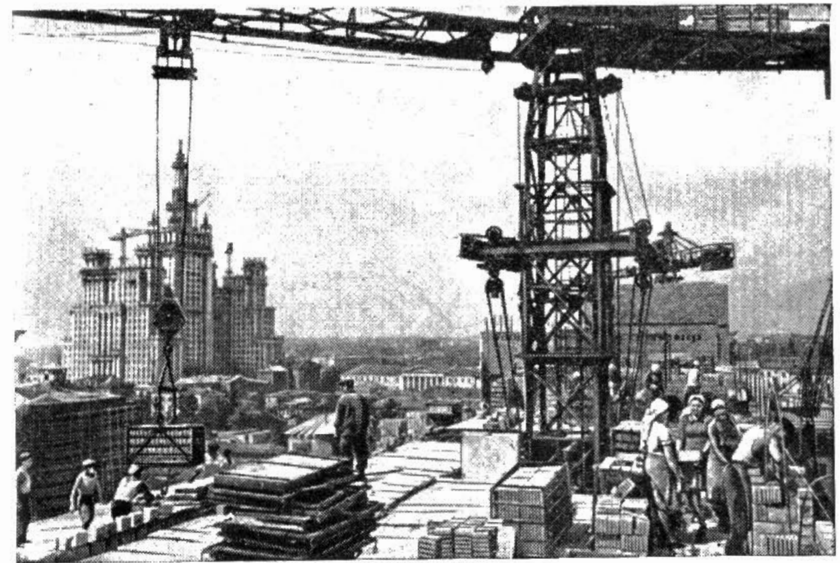
Улица Чайковского. Строительство новых жилых домов.
