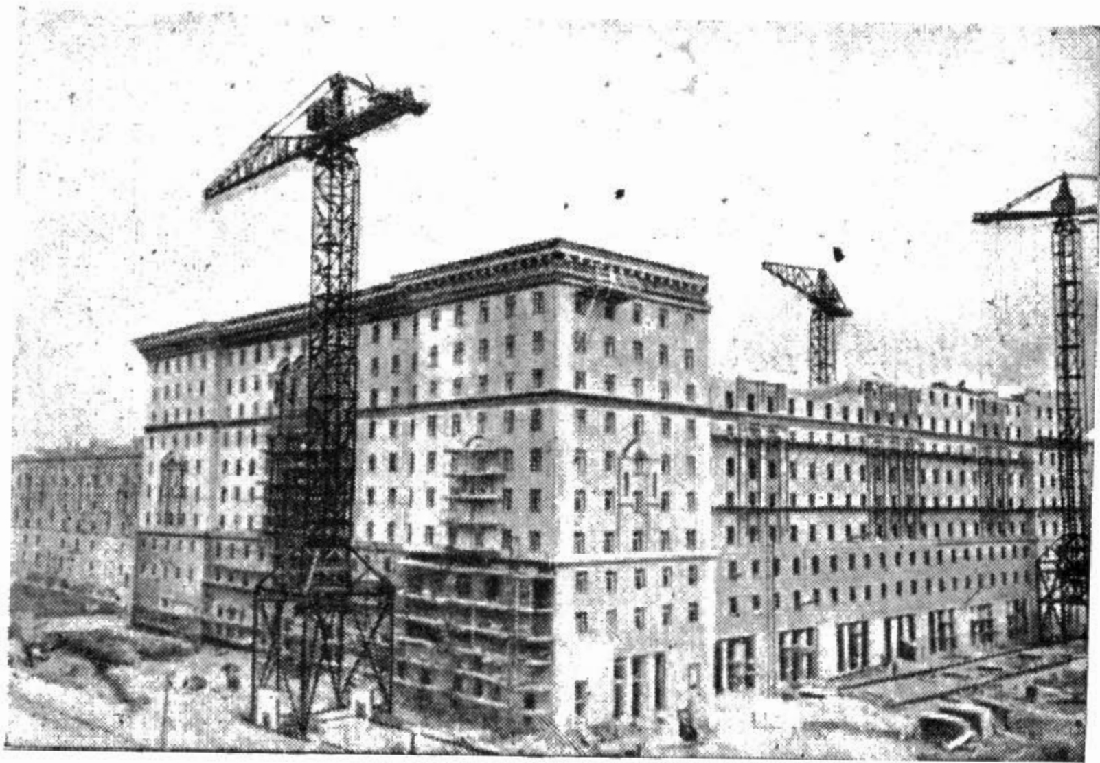
Велозаводская улица. Строительство жилых домов.
