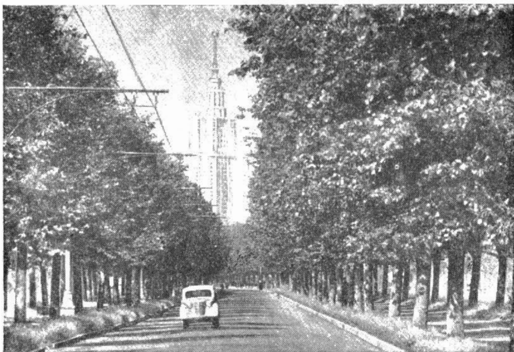
Воробьевское шоссе. Вновь проложенная дорога к зданию МГУ.
