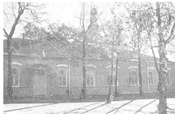
Дом, в котором в 1812 г. размещался госпиталь
