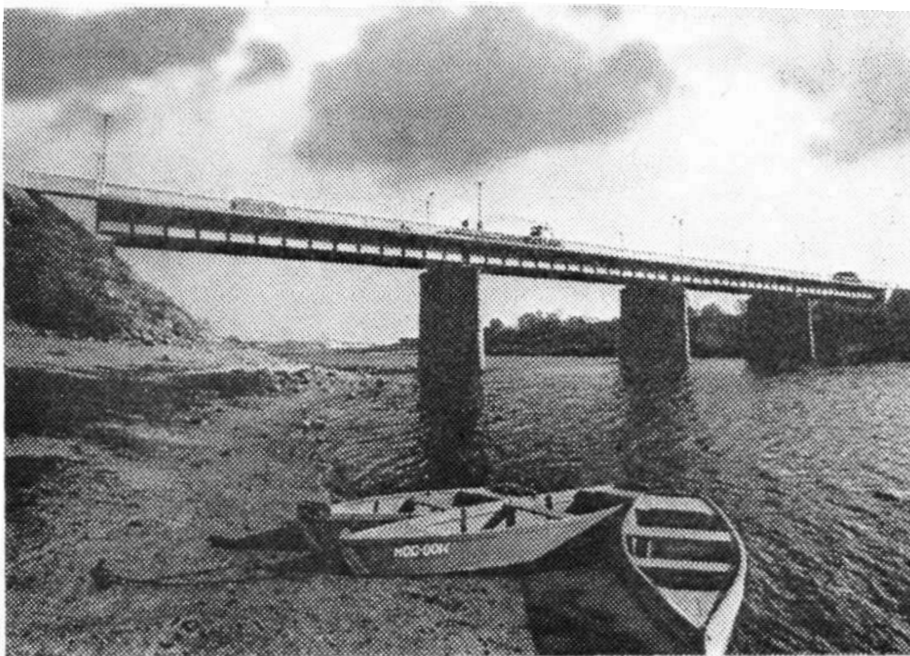
Новый мост через Шелонь.
