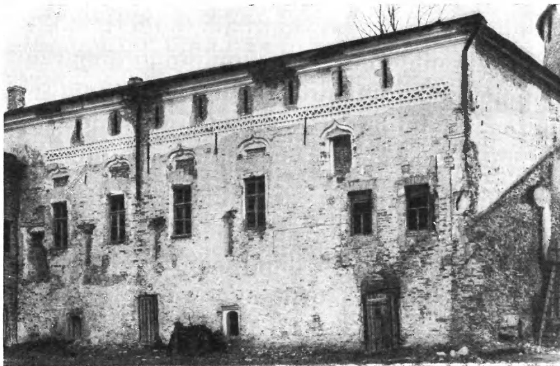
74. Новгород. Архиепископский дворец после раскрытия
