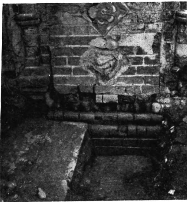
82. Ярославль. Церковь Богоявления. Закладка шурфа с целью раскрыть цоколь
