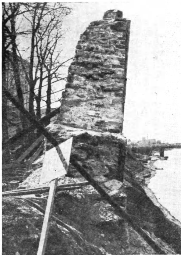
144. Псков. Крепостная стена до выпрямления
