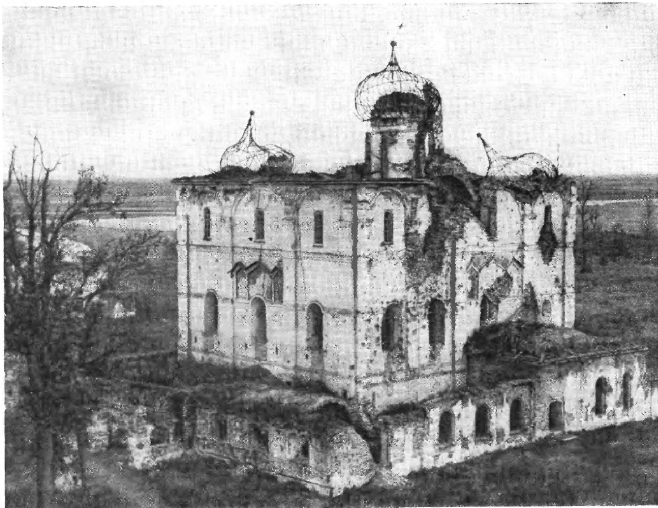
33. Новгород. Собор Хутынского монастыря. Разрушения, причиненные военными действиями
