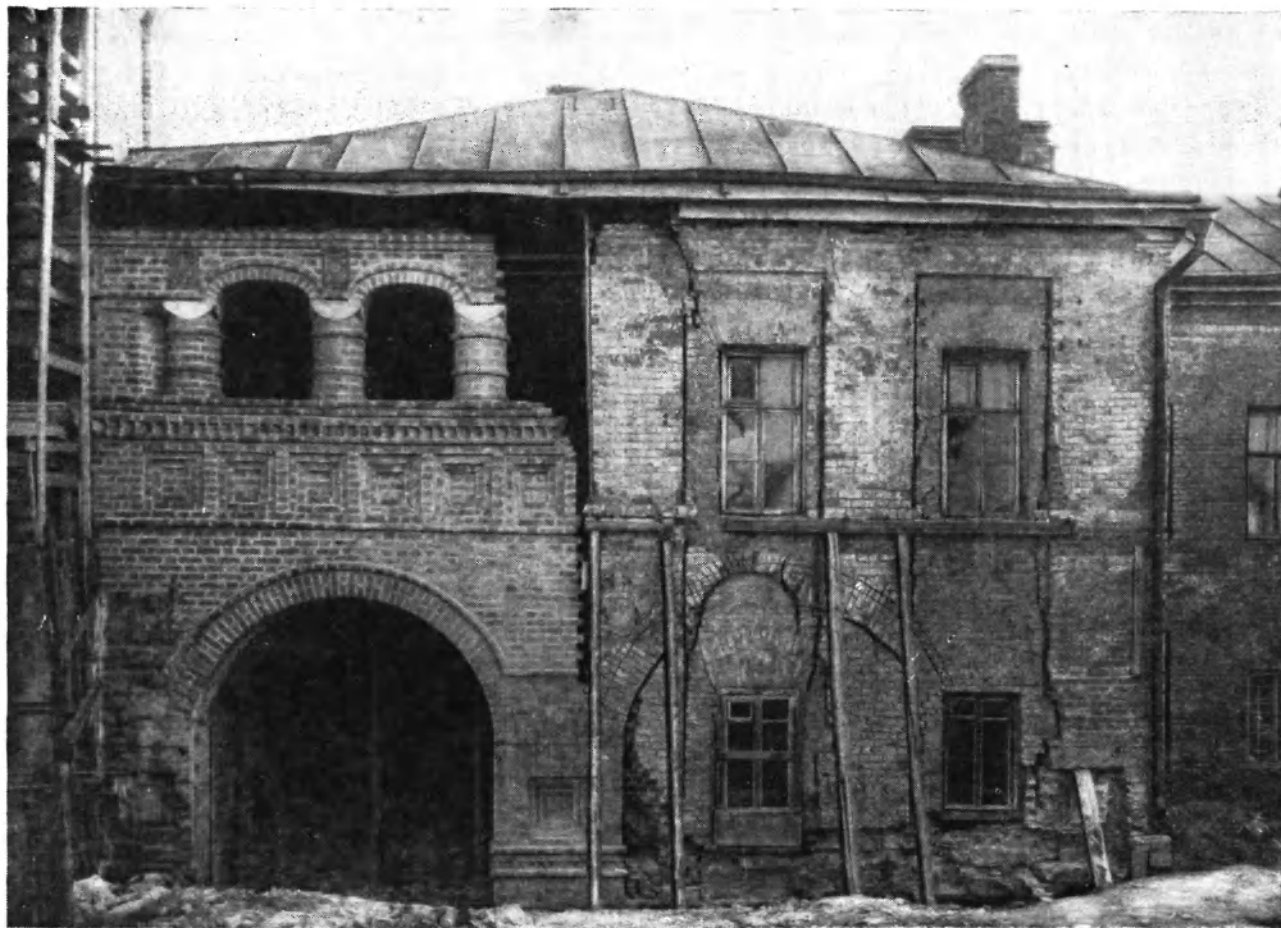
76. Москва. Крутицкое подворье. Надворная постройка XVII в. после частичной реставрации переходной галереи
