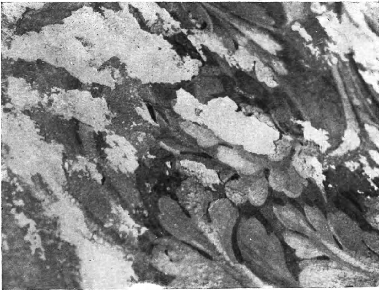
184. Осыпи красочного слоя клеевой живописи и появление «смугли» из-за неисправности кровли во дворце в усадьбе Люблино под Москвой
