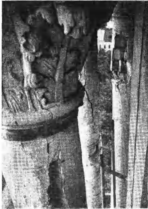
29. Загорск. Колокольня Троице-Сергиевой лавры. Деформации белокаменных колонн
