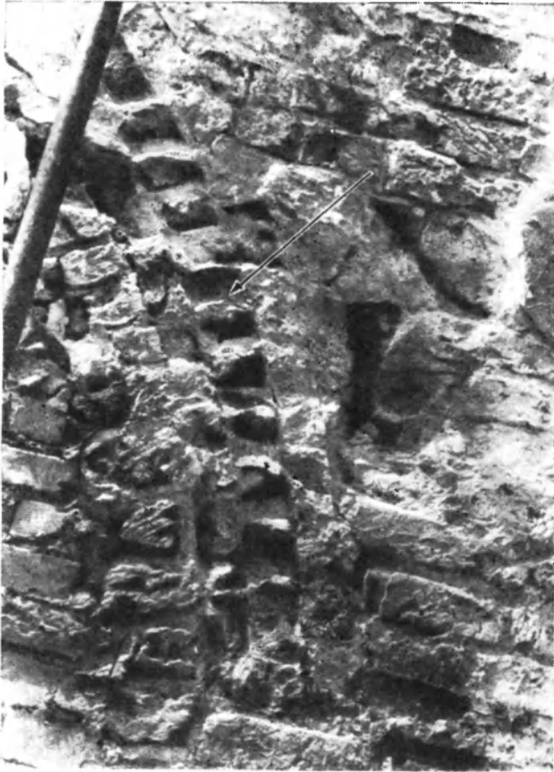
63. Москва. Церковь Знамени на Шереметевом дворе. Следы архивольта арки, вскрытого зондажем в подклете
