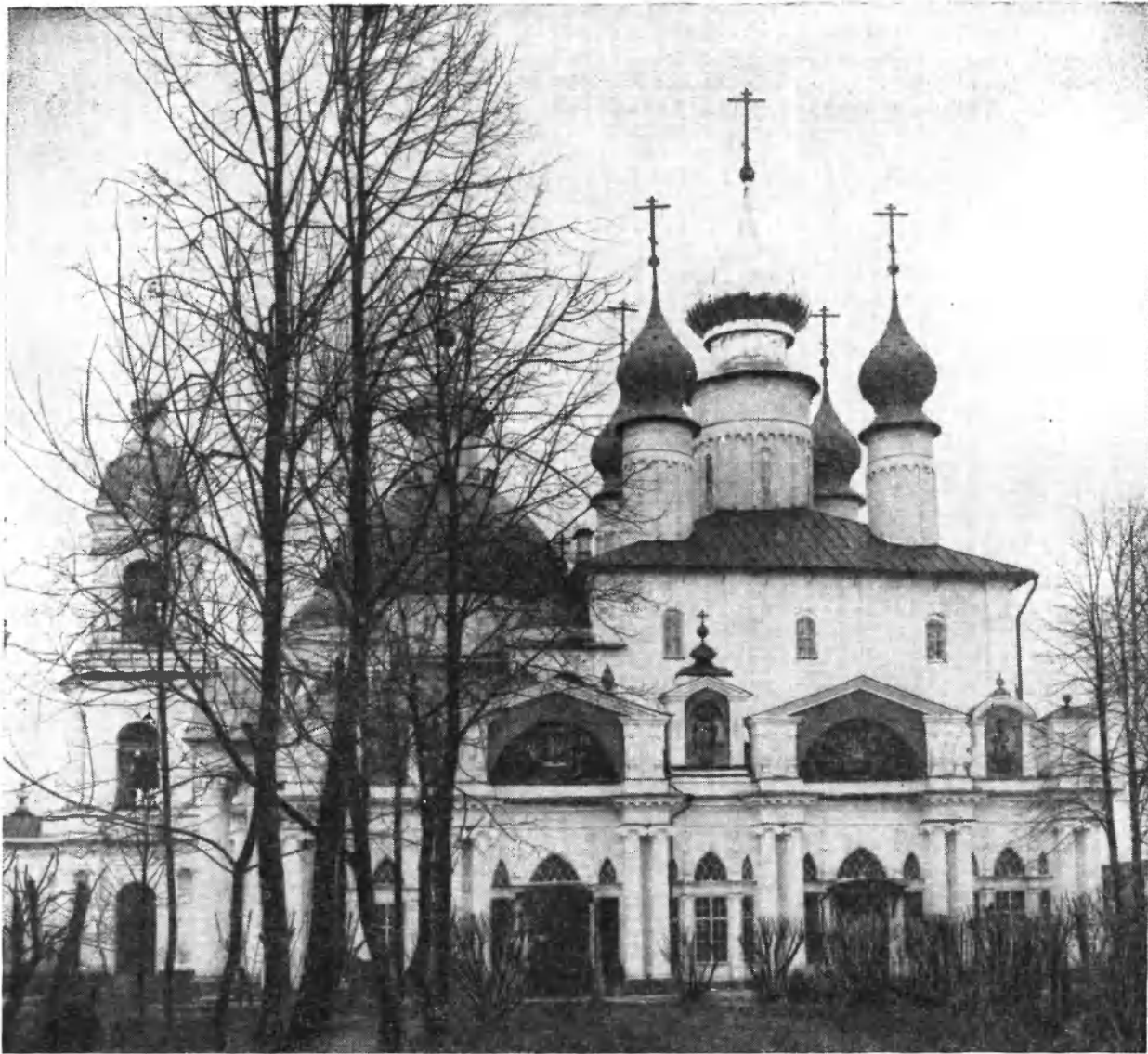
37. Ростов Ярославский. Спасо-Яковлевский монастырь. Зачатьевская церковь. Пример пристройки паперти в XVIII в.
