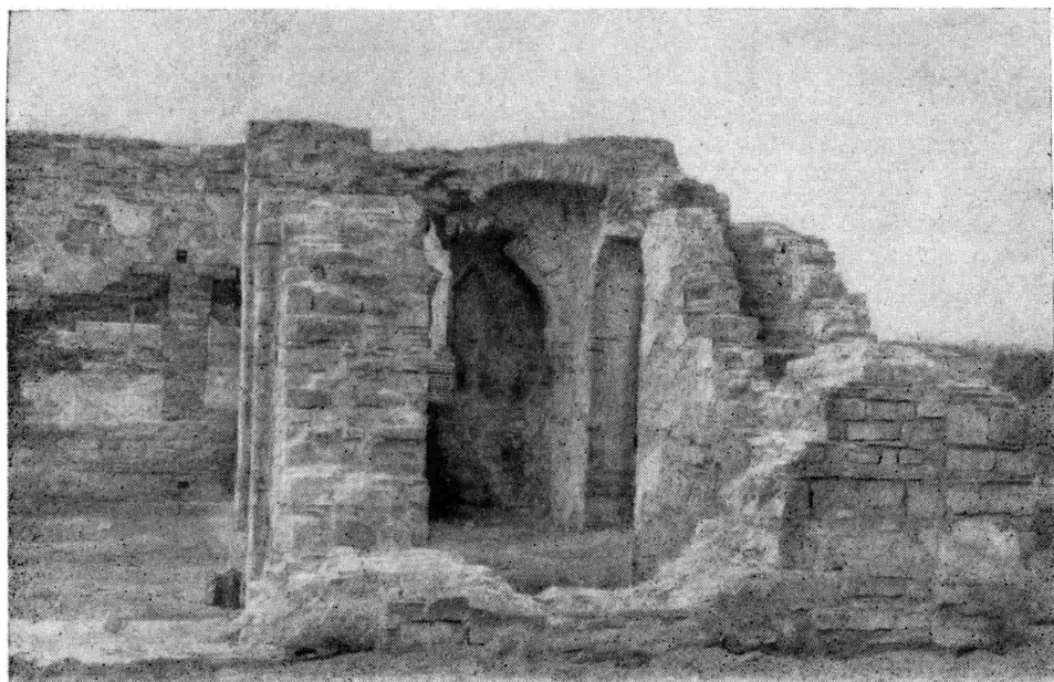
Рис. 3. Церковь Благовещения. Нартекс. Вид с севера
