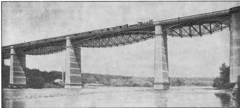
Fig. 11. Eisenbahnbrücke über die Isar bei Großhesselohe, erbaut 1857. Bis 1912 in Benutzung gewesen. (2 Öffnungen von je 54,10 m Spannweite, 2 Öffnungen von je 28,2 m Spannweite.) Originalteile im Deutschen Museum in München.
