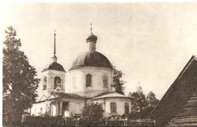
Погост Витожетка. Знаменская церковь. 1809—1820 (архитектор А. А. Трофимов?)
