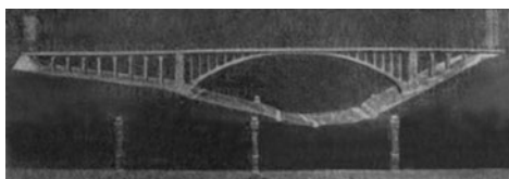
Abb. 15. Modell des Entwurfes der Bernandbrücke, l = 170 m.
