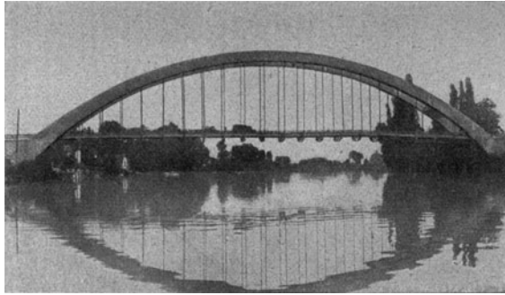
Abb. 9. Seinebrücke bei St.-Pierre-du-Vauvray, l = 131,8 m.
