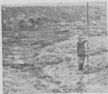
Рис. 23. Работа болотного бульдозера Каттерпиллар на увлажненной почве (верхний снимок). После закладки пруда несущий слой все еще на 1 м ниже ложа пруда. Это демонстрирует установленная рейка.
