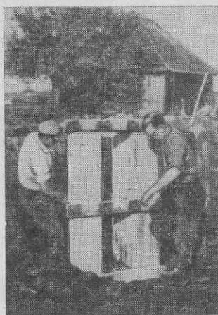
Рис. 15. Опалубка установлена. Некоторые детали соединяют винтами, тогда их можно чаще использовать.
