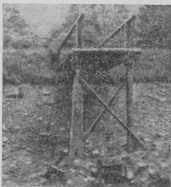
Рис. 133. Заслонка из литого металла в качестве донного водоспуска.
