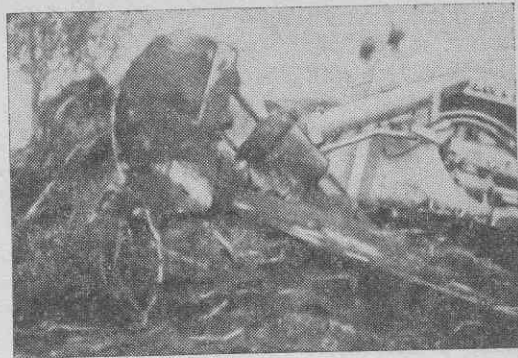
Рис. 22. Болотный бульдозер Каттерпиллар насыпает дамбу (слева). Он сдвигает болотистый, заросший корнями грунт (справа).
