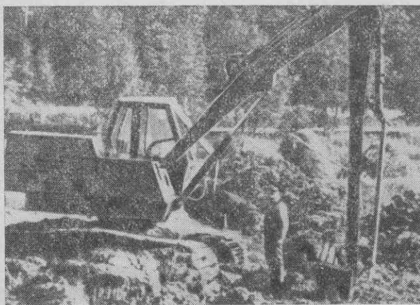
Рис. 21. Экскаватор пригоден для копания канав, в особенности с гребня плотины (слева). Он может также использоваться для сооружения откосов (справа).
