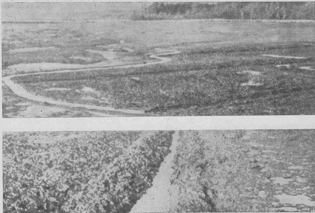
Рис. 28. Проложенные бульдозером боковые каналы имеют хорошее всасывающее действие (верхний снимок). Через 10 мин они заполняются водой (нижний снимок).
