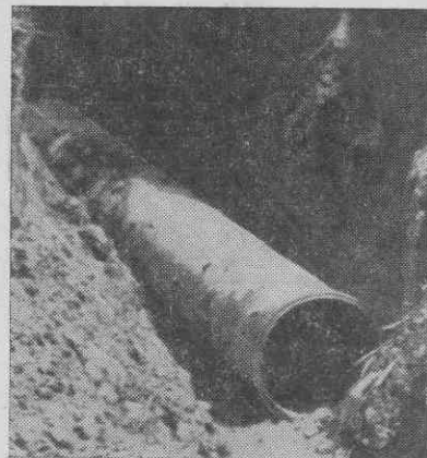
Рис. 14. Пластмассовая труба укладывается без подсыпки на ровное дно канавы.
