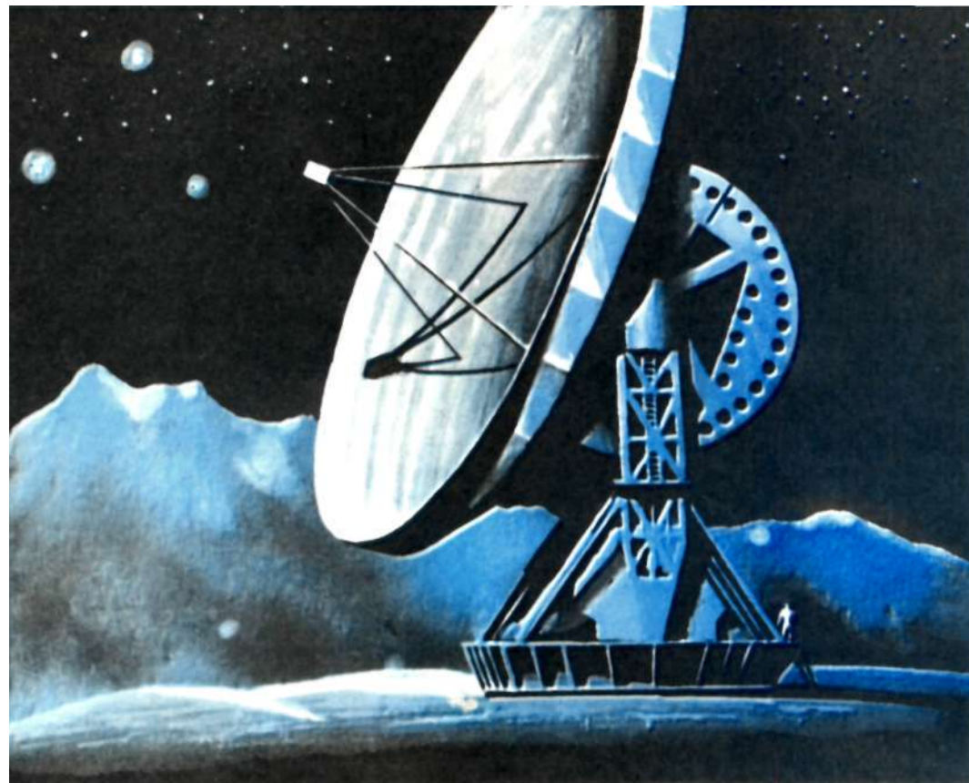
Радиотелескоп Крымской обсерватории в Симеизе. Диаметр зеркала 22 метра.
