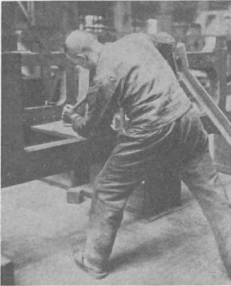
Abb. 34. Arbeitshaltung beim Befellen des Barrenrahmens (verschränkt stehend, Hüfthöhe).
