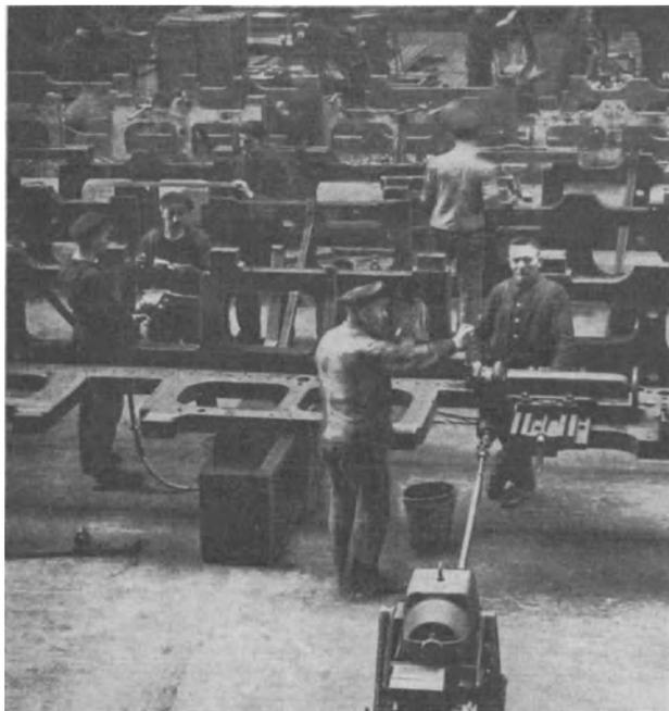
Abb. 11. Bohrarbeiten am Barrerahmen mittels Schlitten und Preßluftbohrmaschine.
