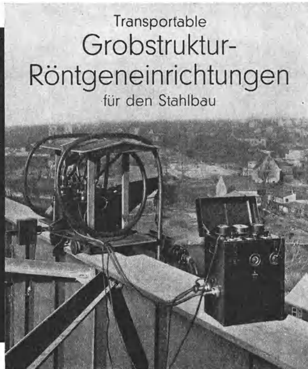
Untersuchung von Schweißnähten am Obergurt einer Brücke
