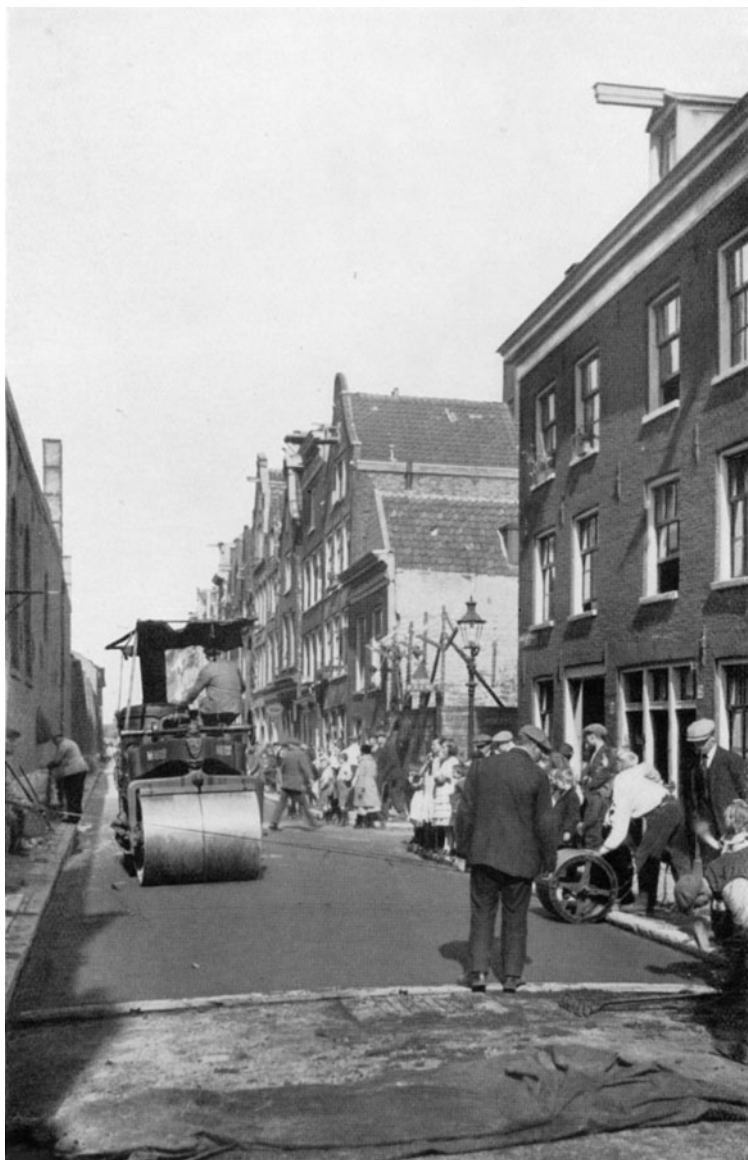
Abb. 8. Festwalzen des Sandasphalts mit einer Tandemwalze von 7 Tonnen.
