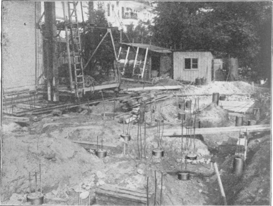
Fig. 31. Baustelle während der Rammarbeiten.
