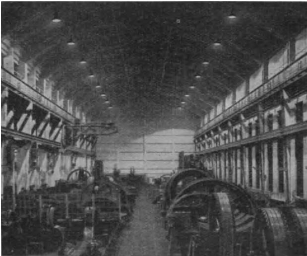
Abb. 114. Hallenbeleuchtung mit großer Lichtpunkthöhe
